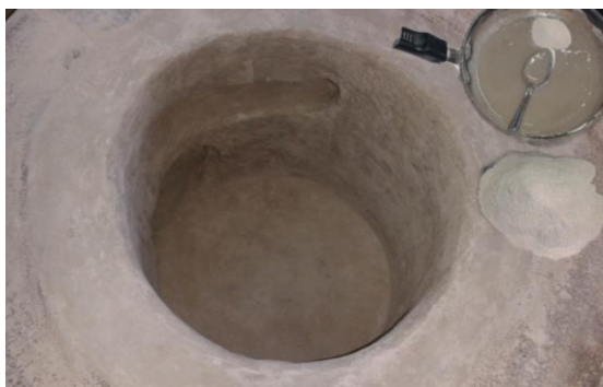
Figura 4.42. Recubrimiento de la pared interna del horno. (Fuente: Elaboración propia)
