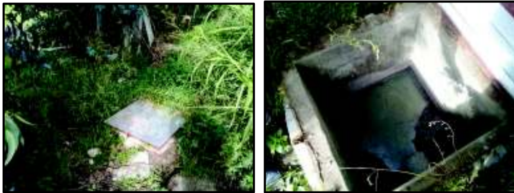
a) Caudal ingresando al pozo
