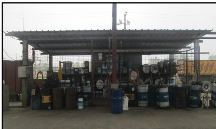
FOTOGRAFÍA 3.13. BODEGA DE ACEITES DEL CAMPAMENTO BASE
