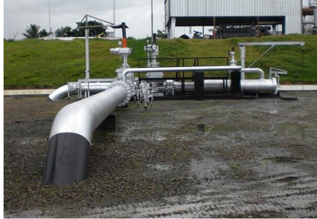
Figura 5.1. Estación de lanzamiento a) Virtual, b) Real.
