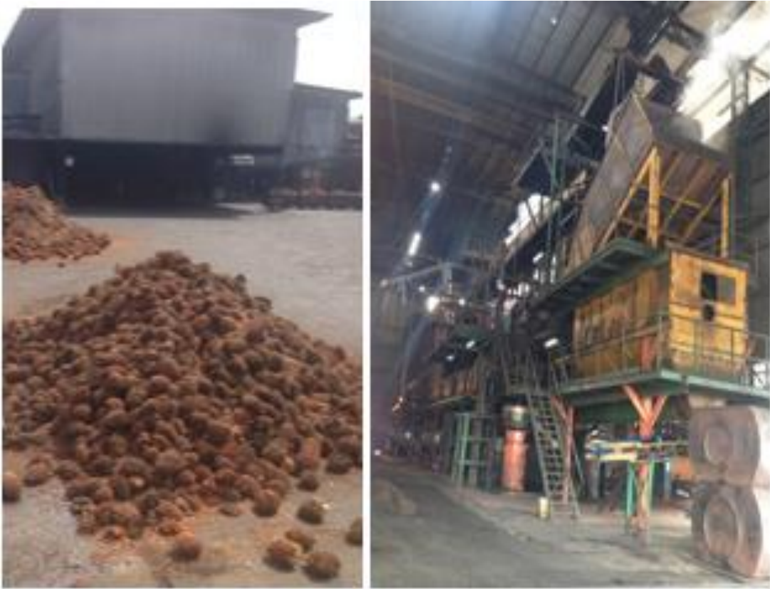
FOTO A3.1: VISITA TÉCNICA A LAS INSTALACIONES DE LA EXTRACTORA PALMAR DEL RÍO
