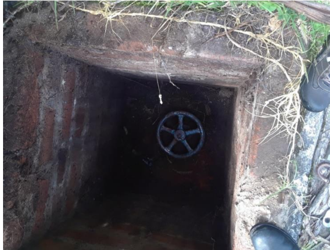
FIGURA 43: VÁLVULAS DE AIRE TIPO COMPUERTA
