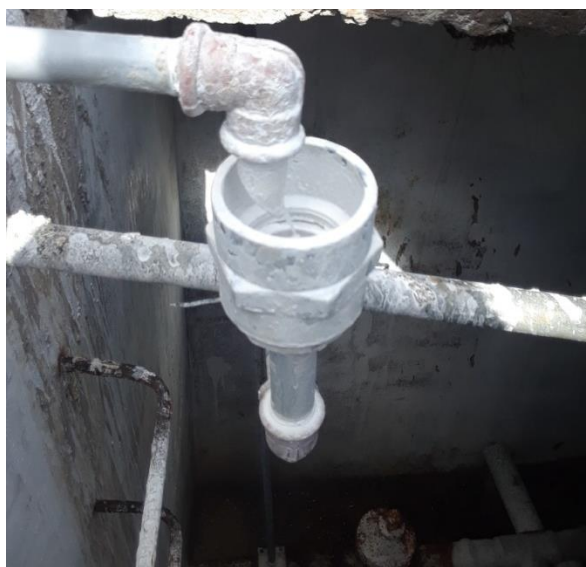
FIGURA 50: SISTEMA DE GOTEO
