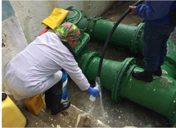
FIGURA 20: TOMA DE MUESTRA EN LA ENTRADA AL AIREADOR
