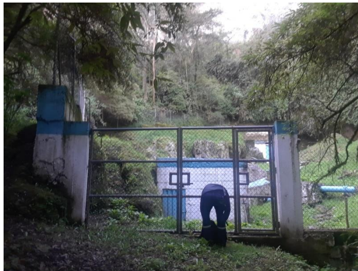
FIGURA 28: CERRAMIENTO PUNTO DE CAPTACIÓN
