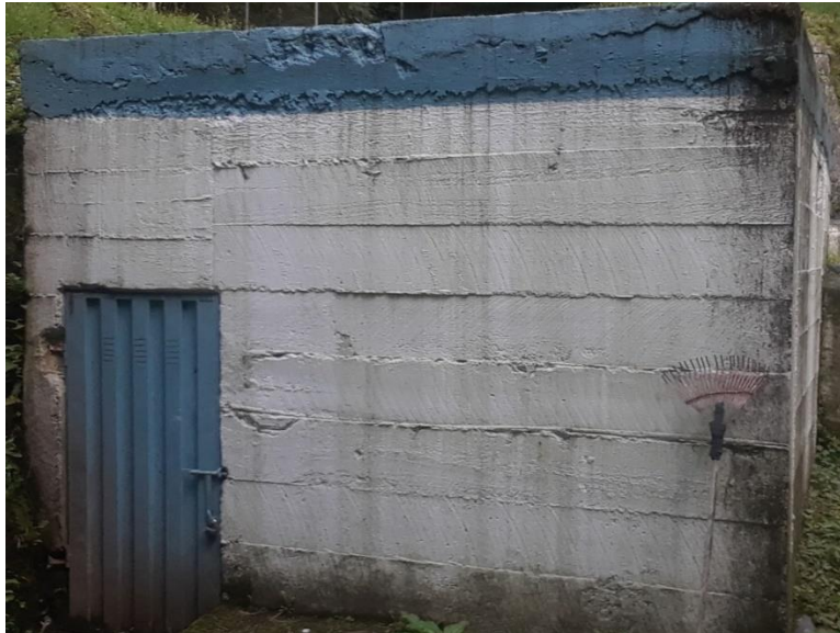
FIGURA 33: TANQUE DE LLEGADA, ESPACIO CAPTACIÓN
