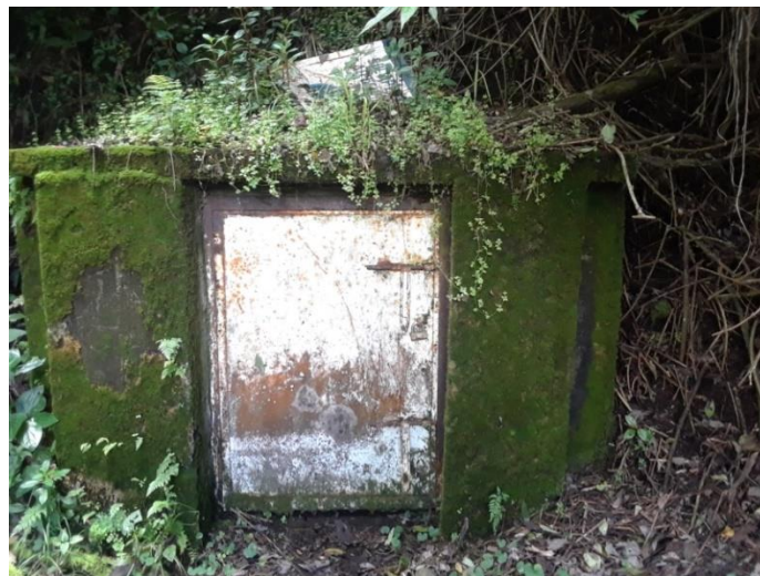
FIGURA 41: SALIDA DEL TÚNEL
