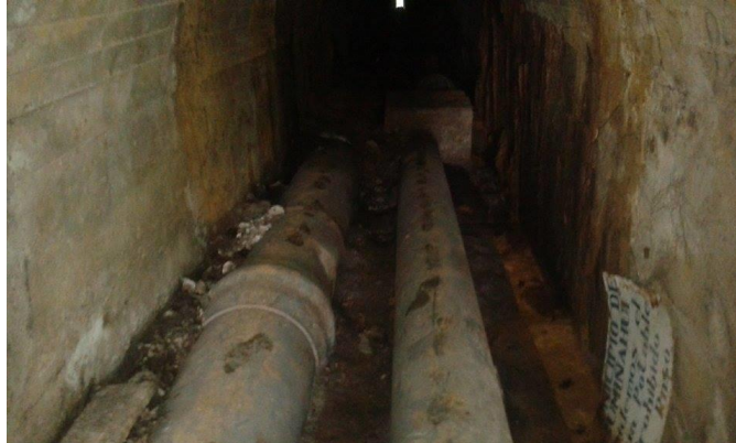
FIGURA 42: INTERIOR DEL TÚNEL
