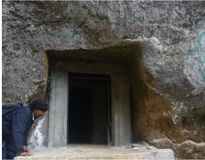
FIGURA 40: ENTRADA AL TÚNEL
