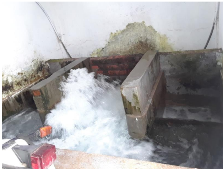
FIGURA 55: TANQUE DEL TANQUE REPARTIDOR DE LORETO
