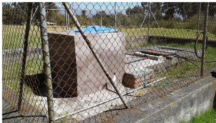
FIGURA 48: TANQUE REDUCTOR DE PRESIONES NÚMERO 1
