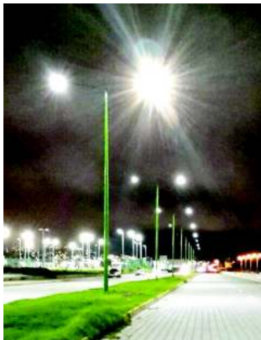
Figura 2.4. Iluminación Vial Av. Camilo Ponce – Ibarra [Autoría Propia]
