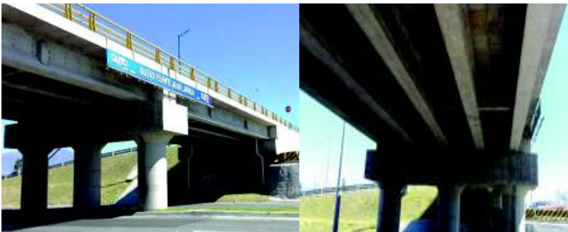
FIGURA 2.5 Puente viga losa Juan Larrea, Pichincha
