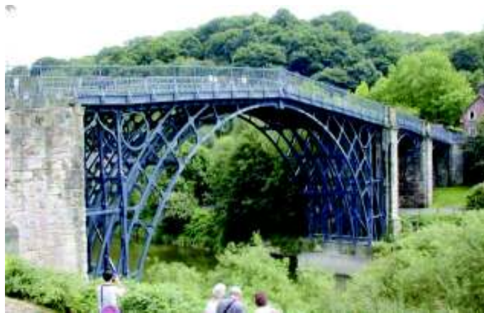
FIGURA 2.3 Puente de Coalbrookdale sobre el río Severn en Inglaterra
