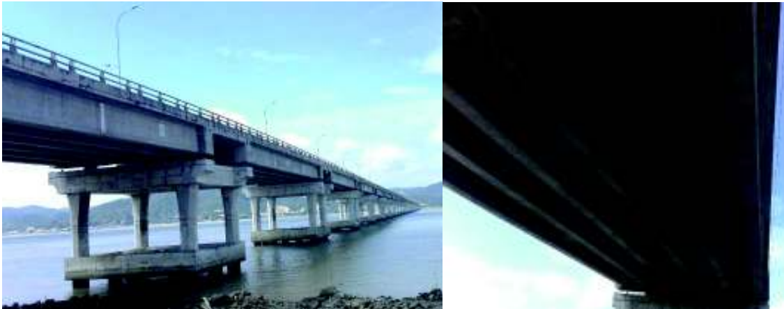
FIGURA 2.6 Puente viga losa Los Caras, Manabí
