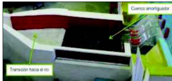
Figura 3.6 Estructuras complementarias situadas aguas abajo de la Presa Toachi
