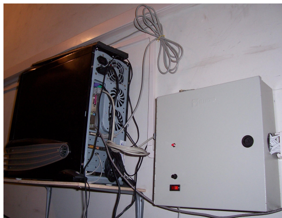
Figura 4.48. Cables de interconexión y sistema total instalado
