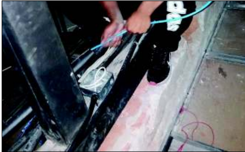
Figura 3.15 Enrutamiento del cableado
