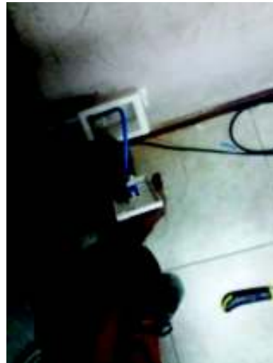
Figura 3.25 Instalación de faceplate en la caja sobrepuesta
