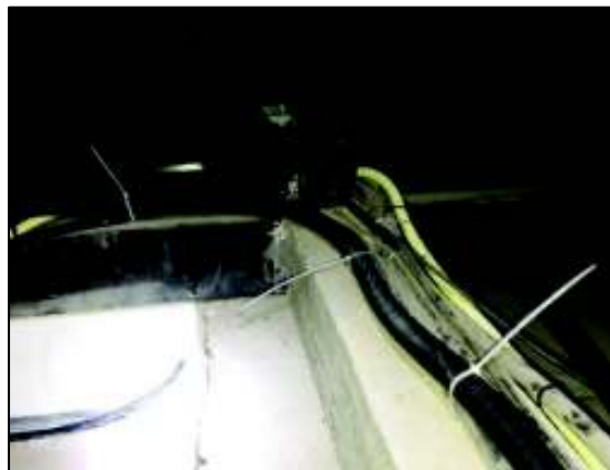
Figura 3.14 Instalación de ductería con amarras plásticas
