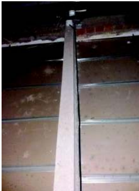
Figura 3.5 Infraestructura de la ESFOT
