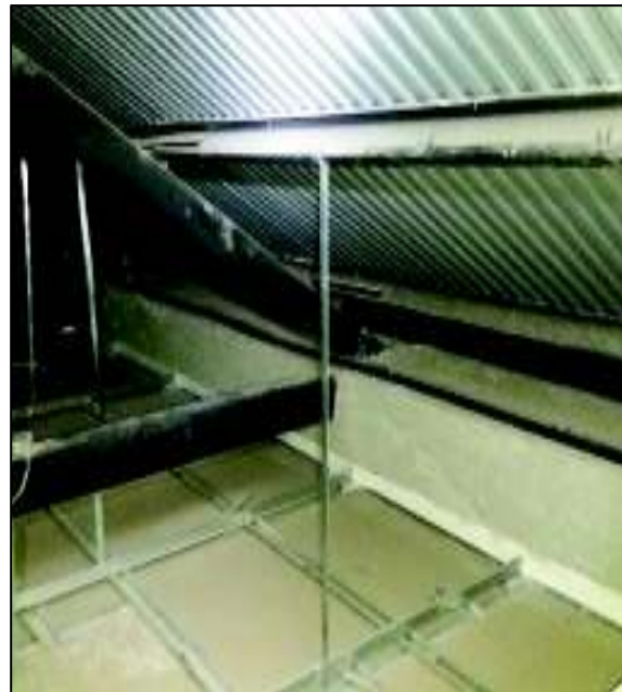
Figura 3.10 Instalación de mangueras PVC
