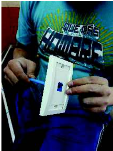
Figura 3.24 Instalación del Jack en el faceplate
