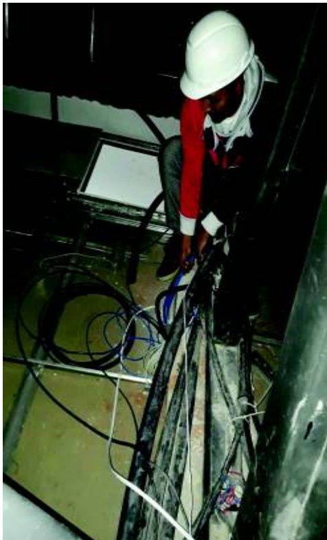
Anexo 8.6 Paso de cable UTP por ductería
