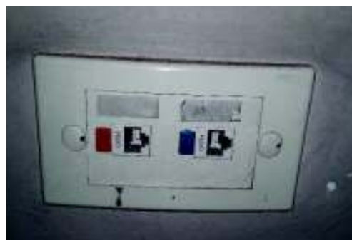
Figura 3.4 Punto de red sin etiquetado
