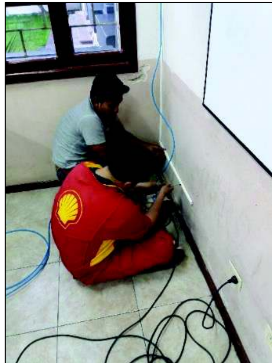
Figura 3.17 Instalación del cable en la canaleta
