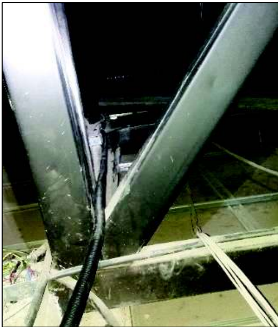
Figura 3.9 Instalación de mangueras PVC corrugada
