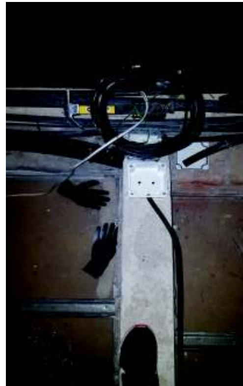
Anexo 8.7 Instalación de cajas de paso
