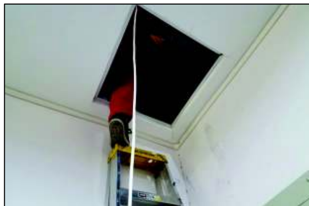
Figura 3.8 Acceso cielo raso oficina 7
