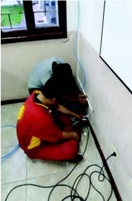
Anexo 8.4 Instalación de canaletas para los puntos de red
