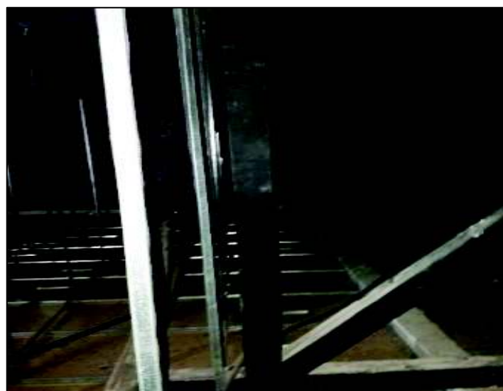
Figura 3.11 Instalación de ductería
