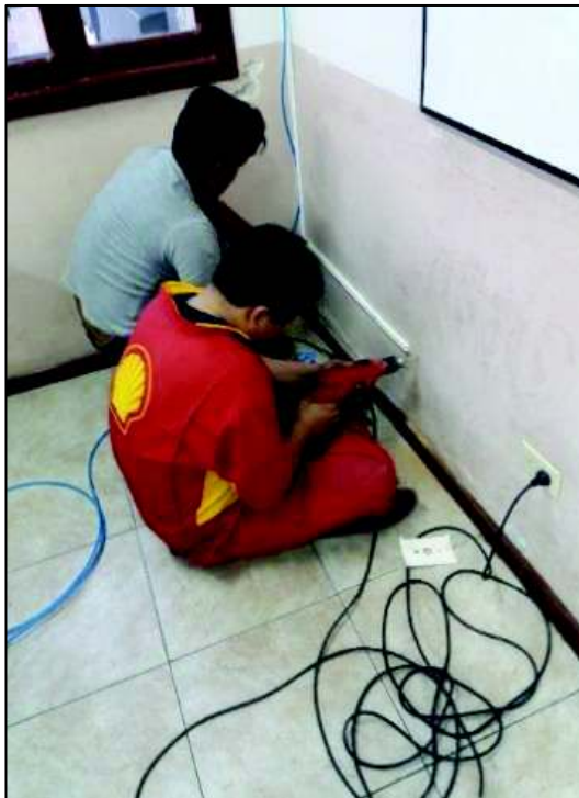
Figura 3.16 Instalación de canaletas
