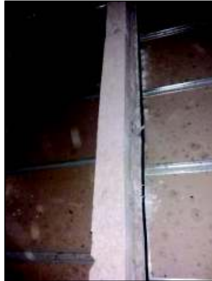
Figura 3.13 Instalación de ductería con abrazaderas metálicas
