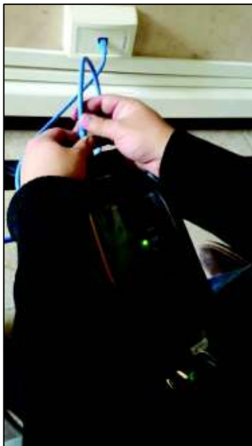
Figura 3.33 Conexión del equipo certificador al punto de red
