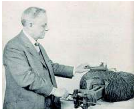
Figura 1.2. Primera soldadora por resistencia con secundario de bobina simple. (Fuente: ACHISOL, 2012)
