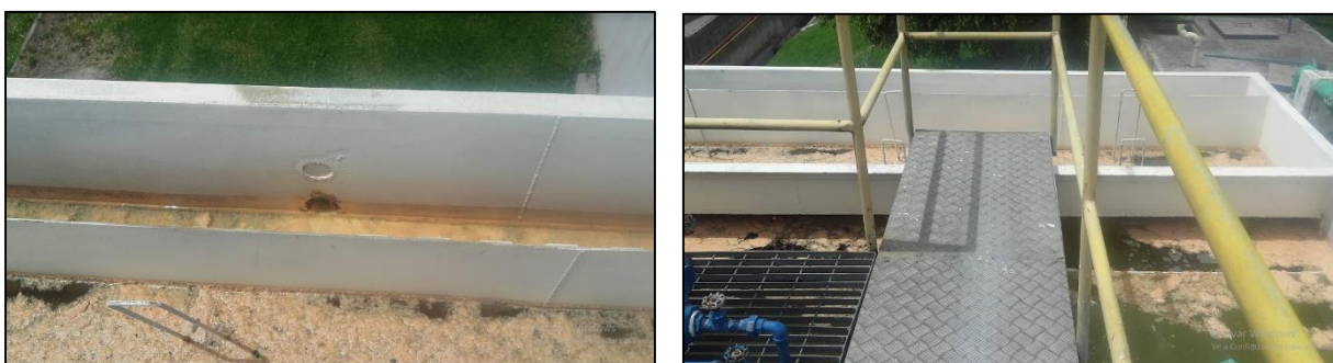
Figura 14. Lodo floculento acumulado en la superficie del sedimentador
