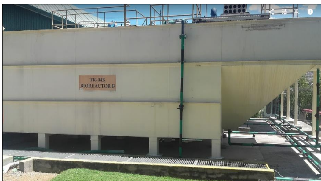
Figura 13. Tratamiento biológico: biorreactores
