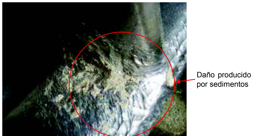
Figura 1.9. Daños causados al rodete de la turbina por sedimentos. (Fuente: CIRT)
