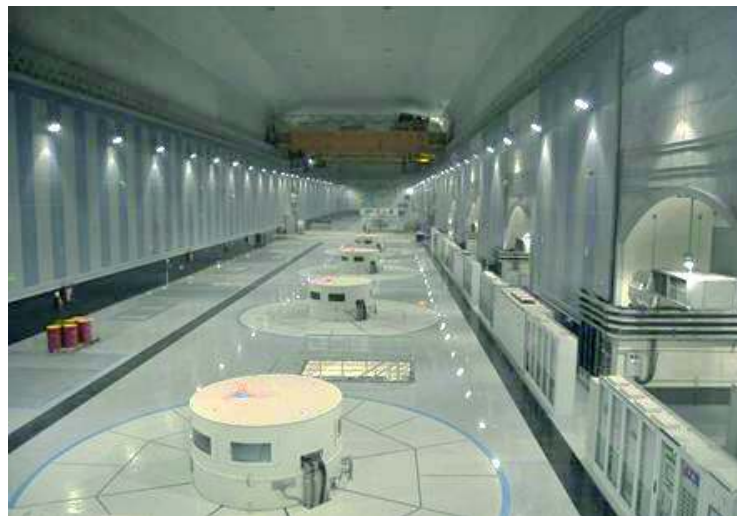
Figura 1.1. Central Coca Codo Sinclair, casa de máquinas. (Fuente: Propia)
