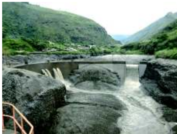
Figura 1.11. Vaciado del embalse de Agoyán. (Fuente: Propia)
