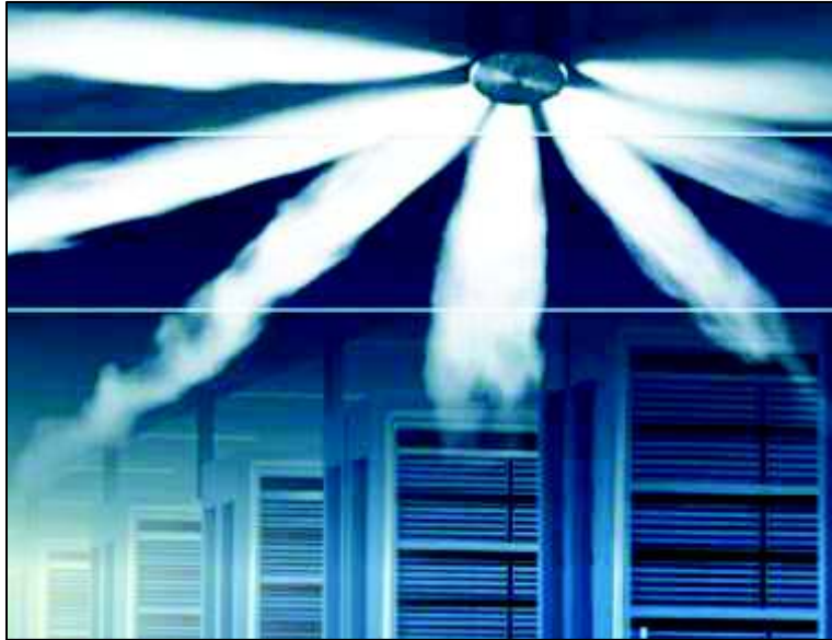
Figura 1.5. Supresión de Incendios sin Agua (gases inertes). (ArchDaily Perú, 2017)
