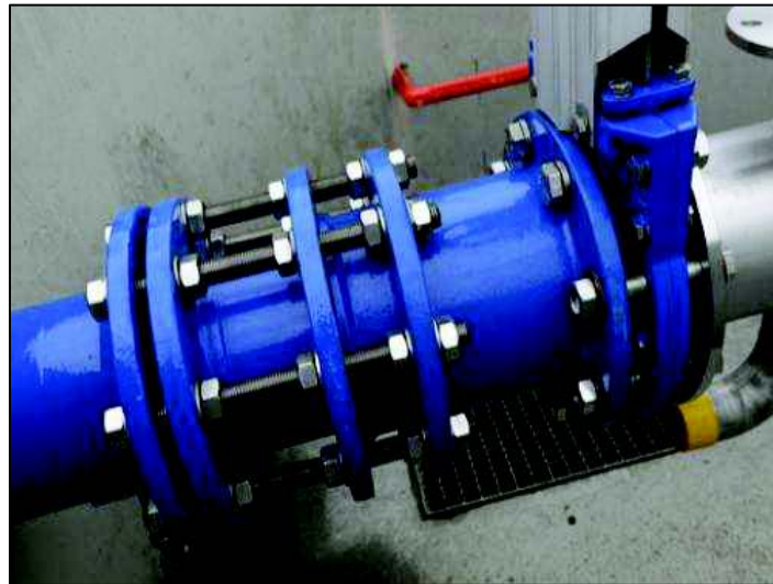
Figura 1.42. Acoplamiento Bridado (Hdosobras, 2017)
