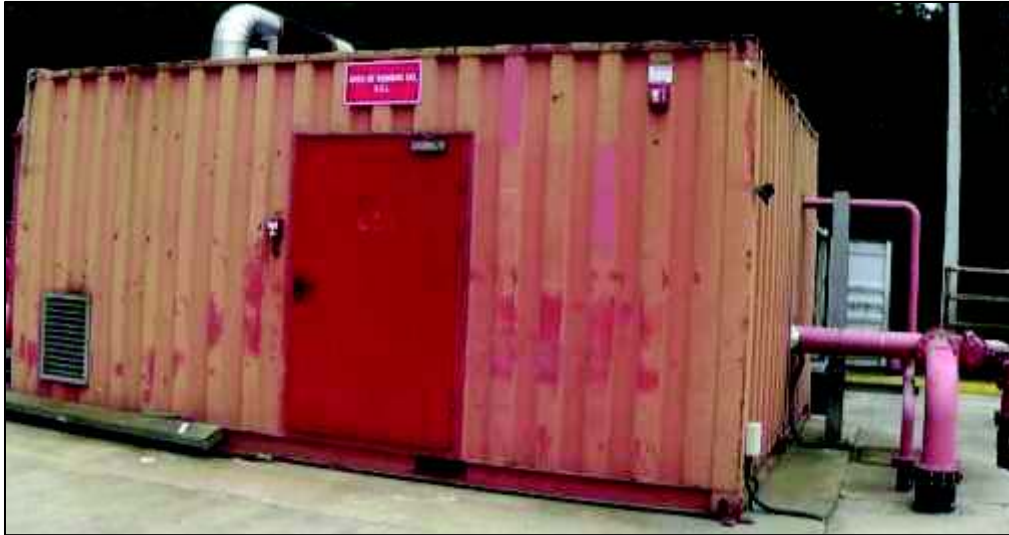
Figura 1.21. Casa de Bombas (vista exterior). (Autor)
