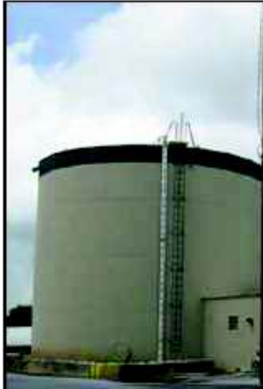
Figura 1.17. Tanque a Nivel del Suelo. (Baja DesignEngineenring, 2016)
