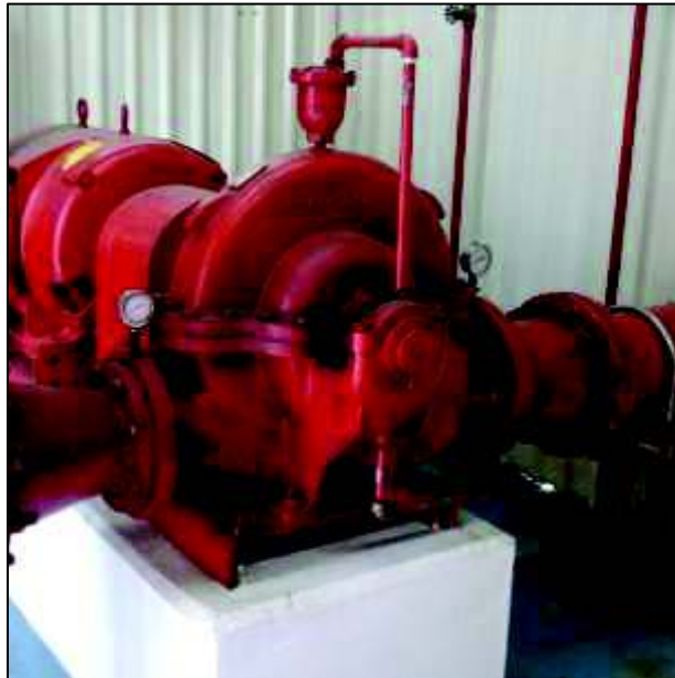
Figura 2.10. Bomba de Carcaza Partida (Balames, 2018)
