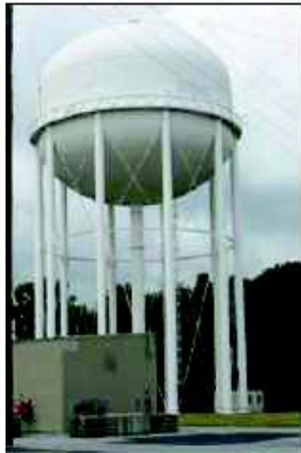
Figura 1.16. Tanque Elevado. (BajaDesignEngineer, 2016)
