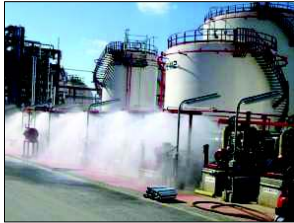
Figura 1.13. Sistema de supresión por diluvio. (SBT Group, 2017)
