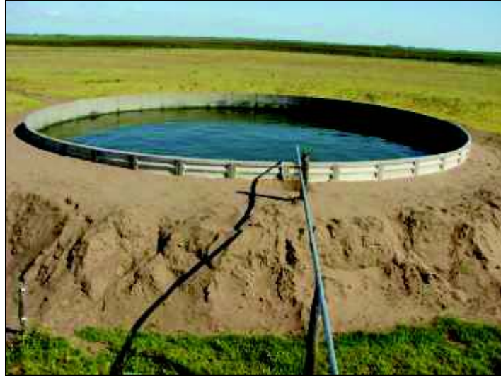
Figura 1.18. Terraplén. (Ali Adalberto, 2008)
