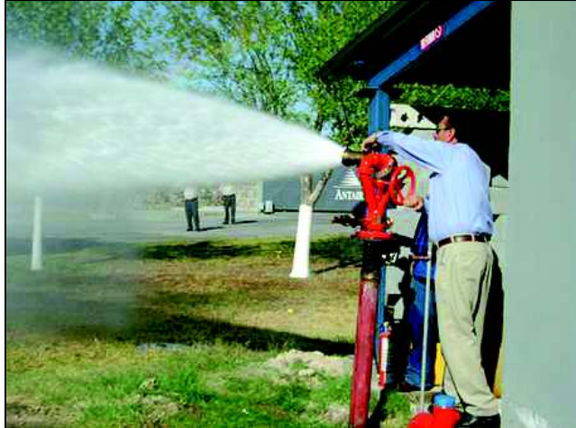
Figura 1.15. Monitor de Agua (F.A manufacturas, 2017)
