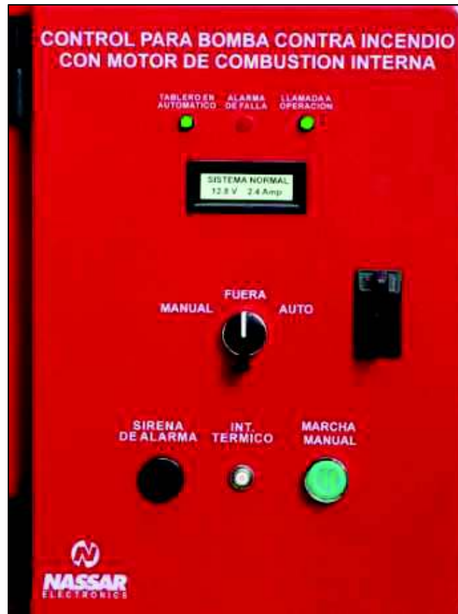
Figura 2.22. Tablero de Encendido y Control. (Autor)
