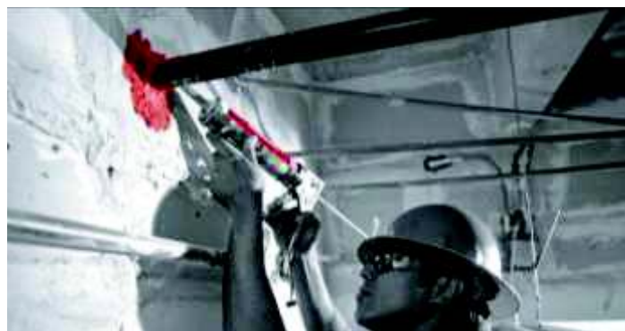
Figura 1.7. Sistema de Fire Stop. (Hilti, 2017)
