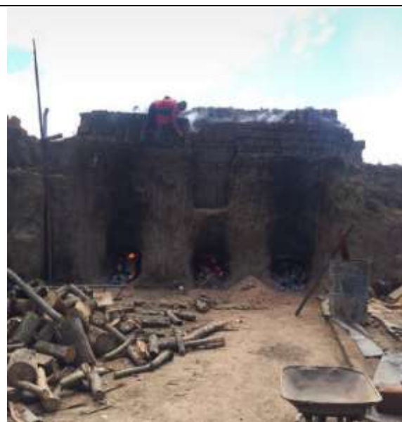
Fotografía 8. Cocción de ladrillos.
