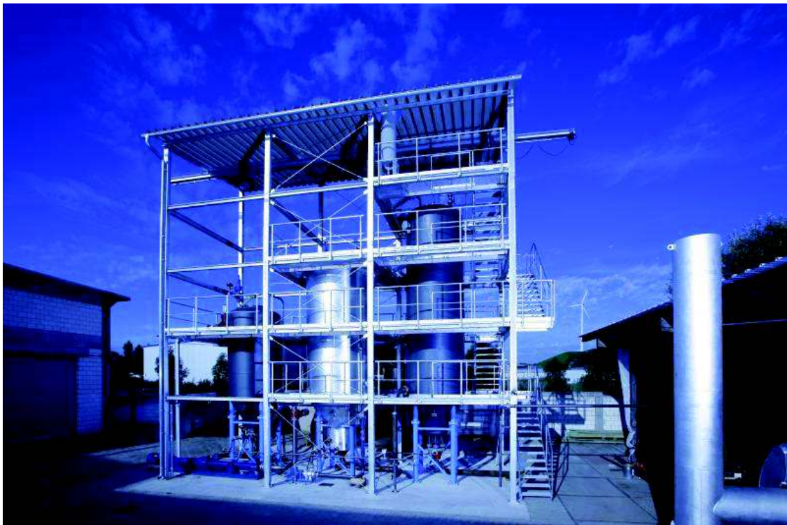
Figura 1.6. Fotografía de la planta HTC-0 en Karlsruhe Alemania. De izquierda a derecha: tanque tapón, reactor y tanque de mezcla. (Fuente: EISMA Businessmedia, 2015)
