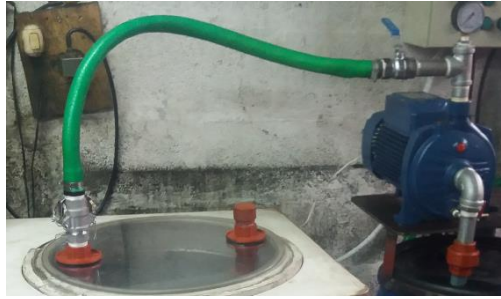
Figura 70. Instalación manguera industrial (Burbano, Oña)
