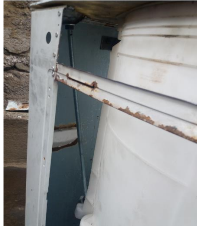
Figura 58. Fijación de tina con ejes roscados (Burbano, Oña)
