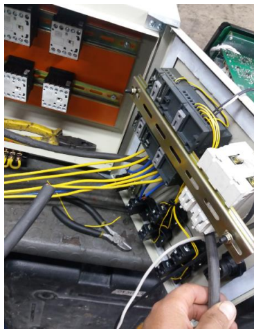
Figura 77. Armado de circuitería eléctrica (Burbano, Oña)
