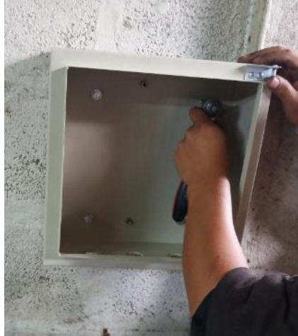
Figura 78. Montaje de gabinete metálico (Burbano, Oña)
