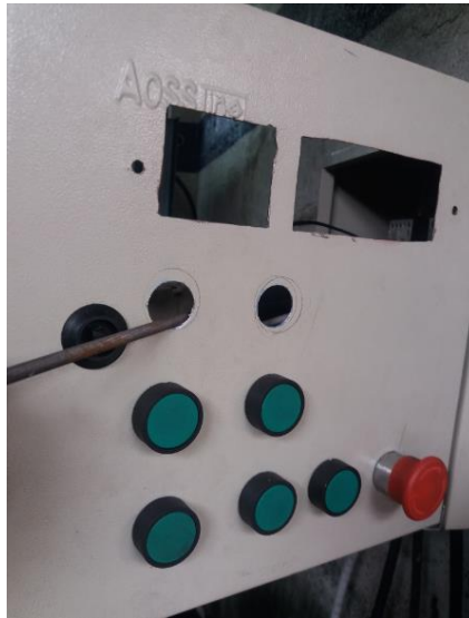
Figura 76. Montaje de equipos en gabinete metálico (Burbano, Oña)
