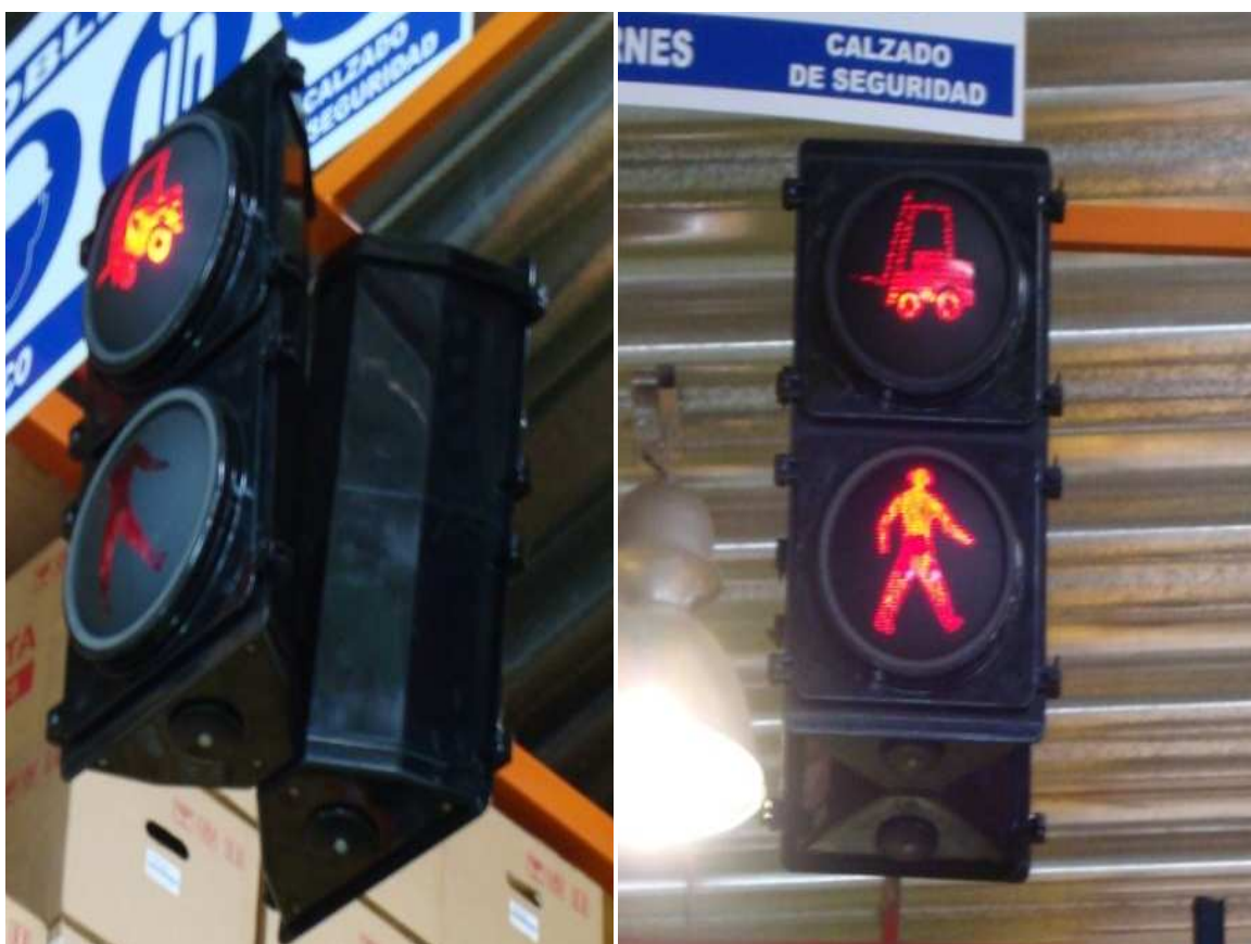
Figura 2.14. Semáforos instalados
