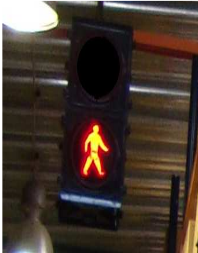
Figura 2.17. Indicador de ingreso de montacargas
