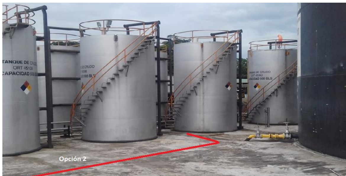
Figura 2.4. Área dentro del cubeto del tanque de lavado
