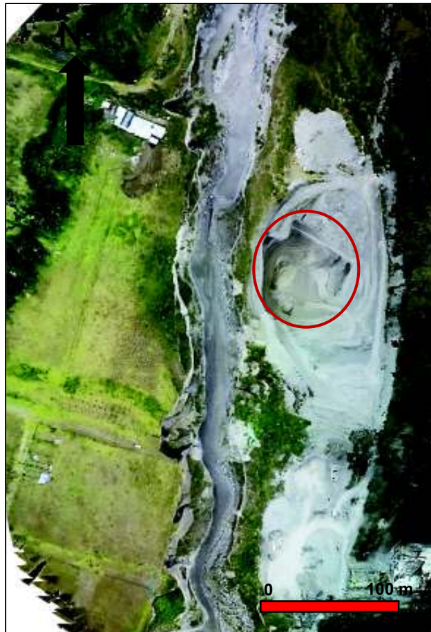
Figura 2. 4 Cantera Terraza Quebrada Blanca 2, muestra una excavación de más de 10 m de profundidad (círculo rojo). Imagen tomada con Dron y procesada con Pix4D.
