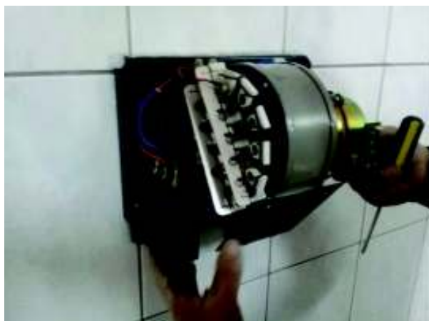
Ilustración 67 Remoción del secador de manos para realizar las conexiones eléctricas.
