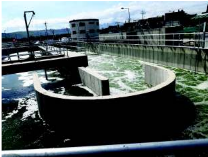
Ilustración 5 Planta de Tratamiento de Aguas Residuales de Quito. (E.P metropolitana de Agua Potable y Saneamiento, 2017)
