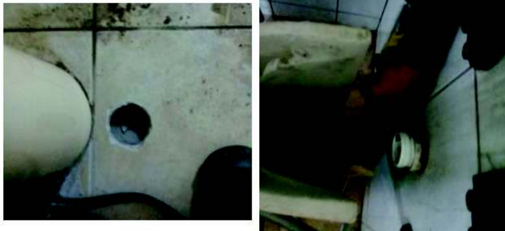
Ilustración 59 Perforaciones en el piso para las conexiones eléctricas.
