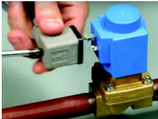
Ilustración 74 Desconexión del transformador
