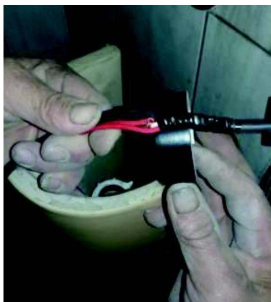
Ilustración 62 Empalme y aislamiento de las conexiones eléctricas que cierran el circuito.
