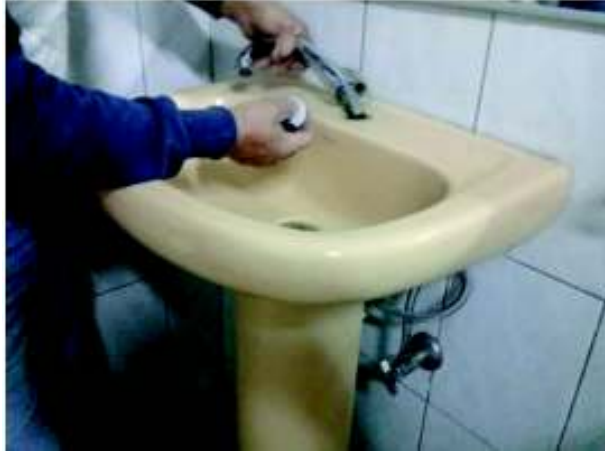
Ilustración 66 Colocación del grifo.
