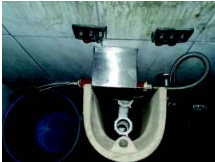
Ilustración 65 Ejecución de pruebas para verificar el correcto funcionamiento de la electroválvula.
