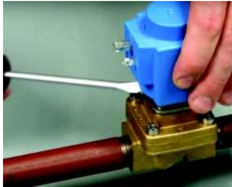
Ilustración 75 Desmontaje de la bobina
