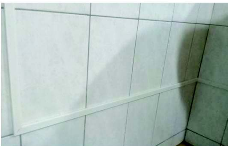
Ilustración 68 Instalación de las canaletas para las conexiones eléctricas.
