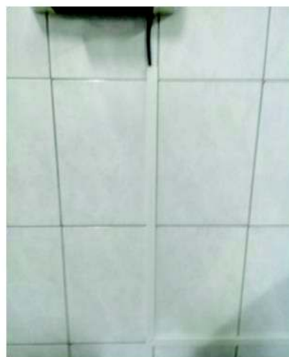
Ilustración 68 Instalación de las canaletas para las conexiones eléctricas.
