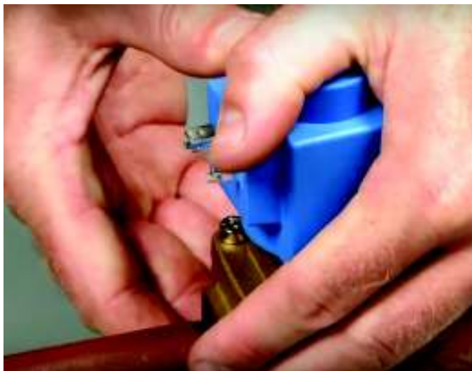
Ilustración 84 Instalación de la bobina
