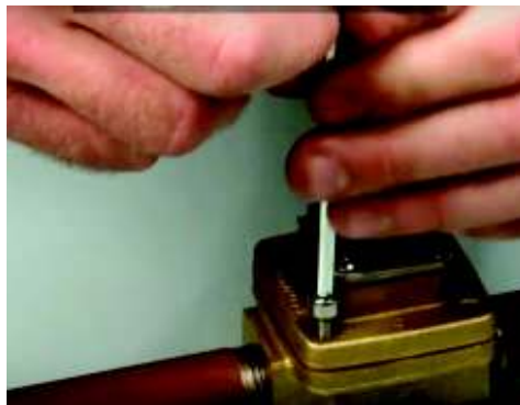
Ilustración 76 Desmontaje de la tapa
