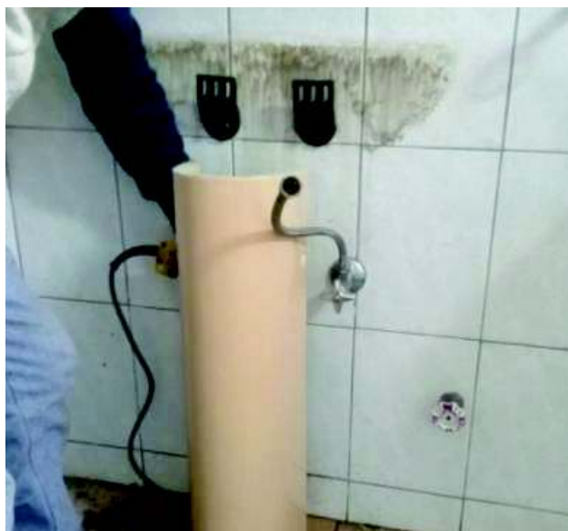
Ilustración 58 Remoción del lavamanos 01.
