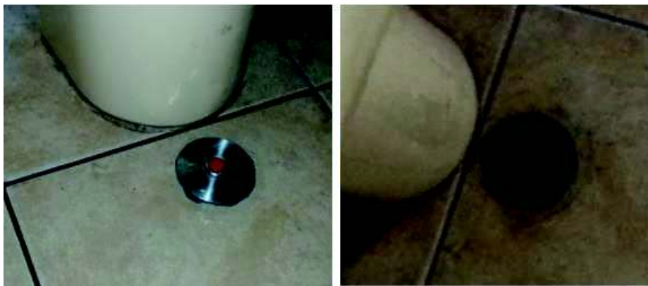
Ilustración 70 Instalación del protector para el pulsador.
