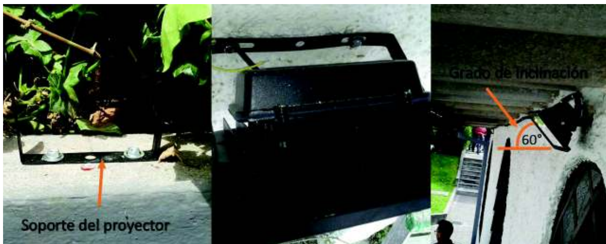
Figura 3.17. Montaje de las luminarias Fuente: Propia
