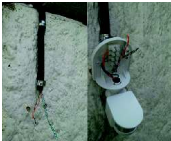
Figura 3.18. Tendido del cable UTP y montaje del sensor de movimiento Fuente: Propia
