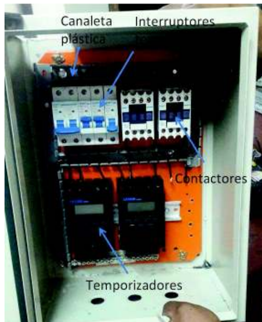
Figura 3.20. Colocación de los elementos de protección y control Fuente: Propia
