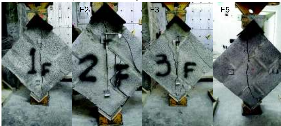
FIGURA 4.32: Falla típica a tensión diagonal de los muretes:
