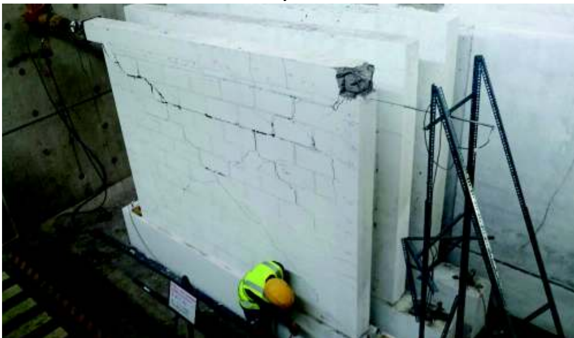
FIGURA 5.20: Pórtico A al final del ensayo:
