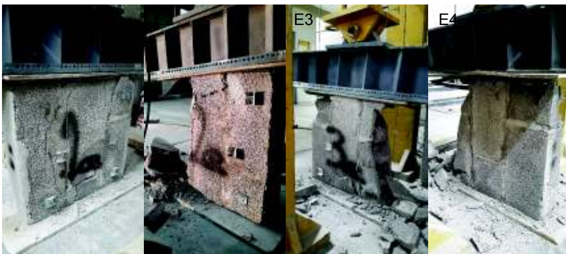
FIGURA 4.21: Fallas típicas de los muretes tipo E:
