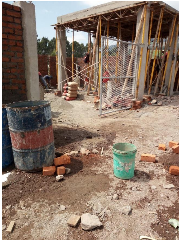
Figura 65 Estación de bombeo en construcción Cunchibamba (Barrio San Pablo). Fotografía tomada por Sebastián Bombón.
