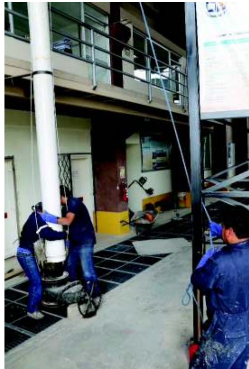
Fotografía No. 2: Desmontaje de la tubería de presión
