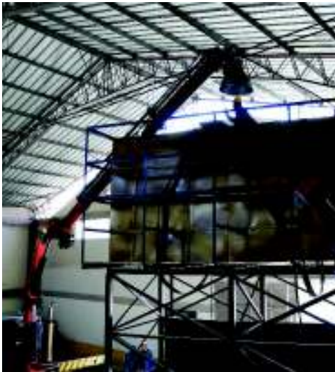
Fotografía No. 4: Reubicación del tanque de abastecimiento
