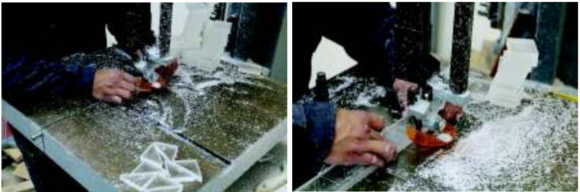
Fotografía No. 2: Corte de placas de acrílico, previamente realizado el trazado de los tabiques triangulares
