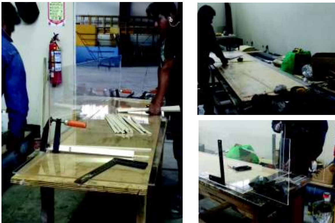
Fotografía No. 13: Construcción del canal de descarga
