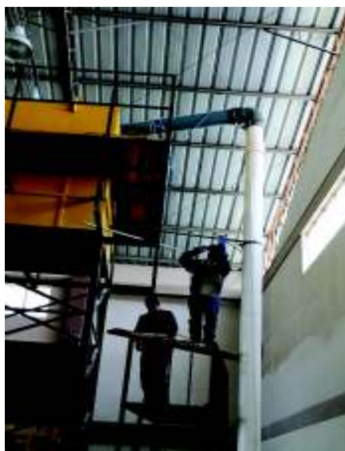
Fotografía No. 6: Colocación de la tubería a presión, junto con sus accesorios
