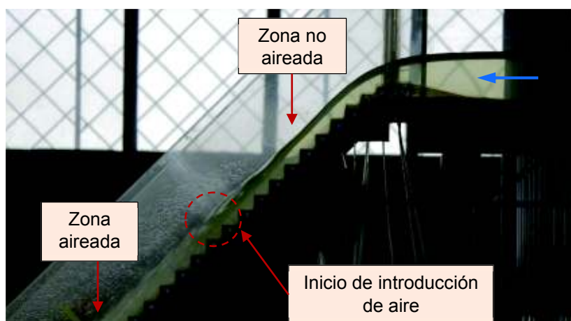
Fotografía No. 4.57: Prueba 3. Vista lateral izquierda del inicio de la rápida escalonada, se puede observar el comienzo de la introducción de aire
