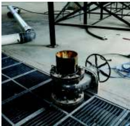
Fotografía No. 5: Colocación de la válvula de compuerta
