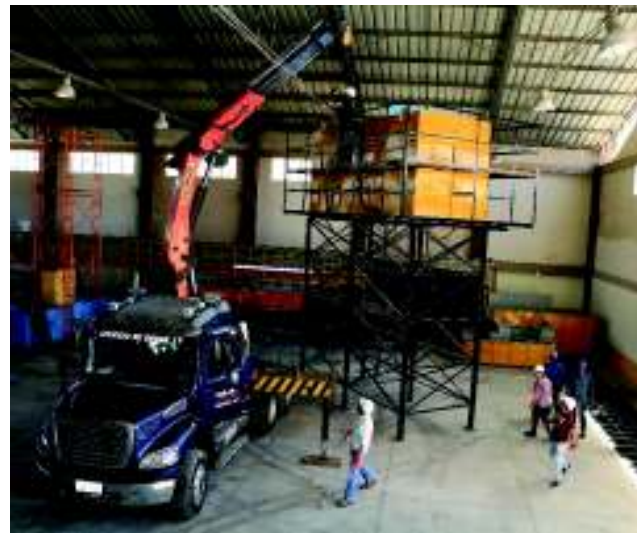
Fotografía No. 4: Reubicación del tanque de abastecimiento
