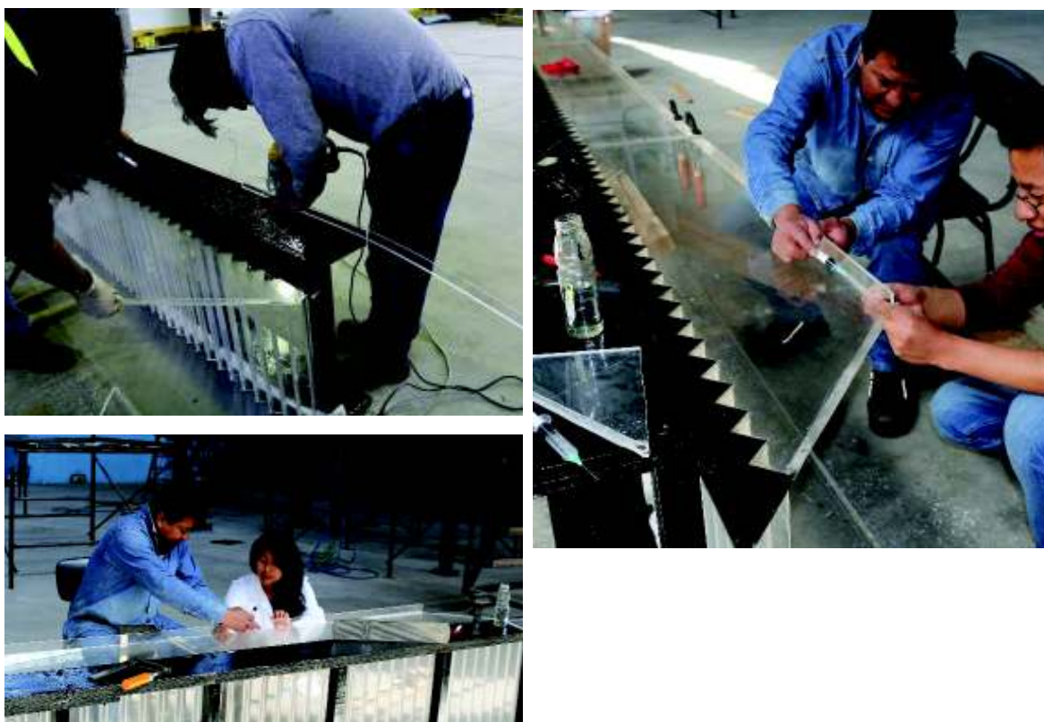
Fotografía No. 19: Colocación de rigidizadores en las paredes de la rápida escalonada
