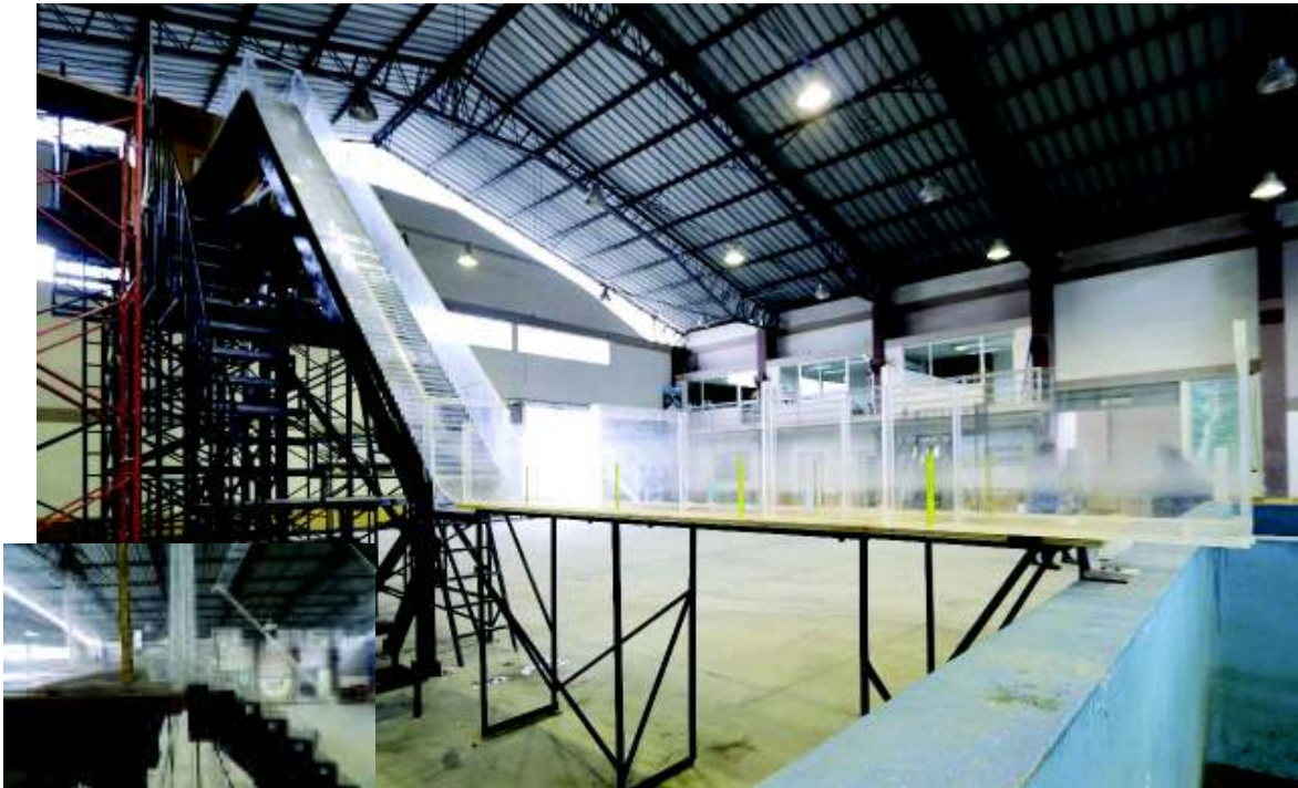
Fotografía No. 3.5: Rápida escalonada construida en acrílico
