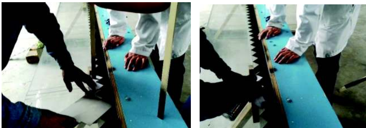
Fotografía No. 17: Pintura en la rápida escalonada
