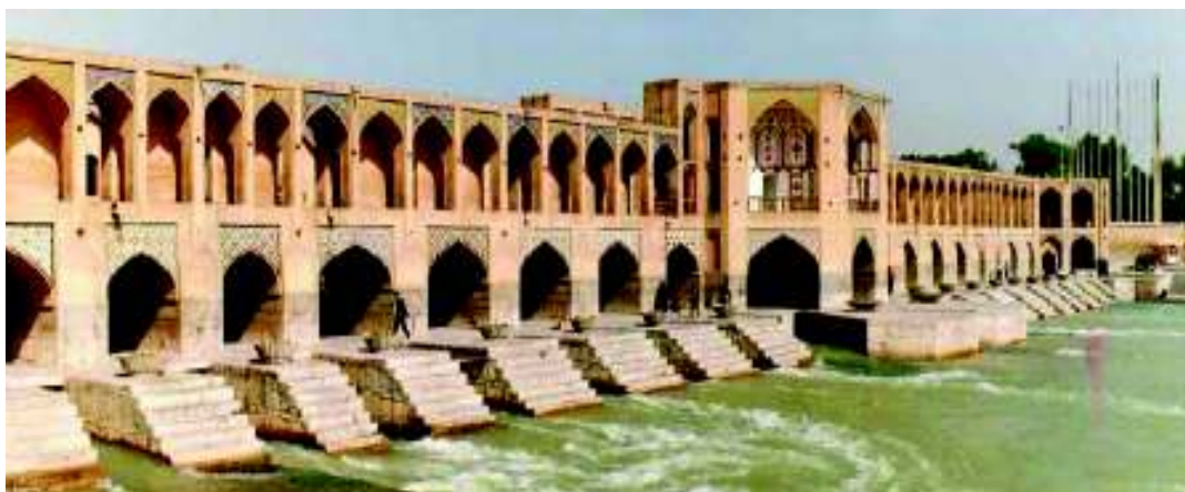
Figura No. 1.2: Vertedero del río Khajoun (Persia Grecia D.C 1.650)
