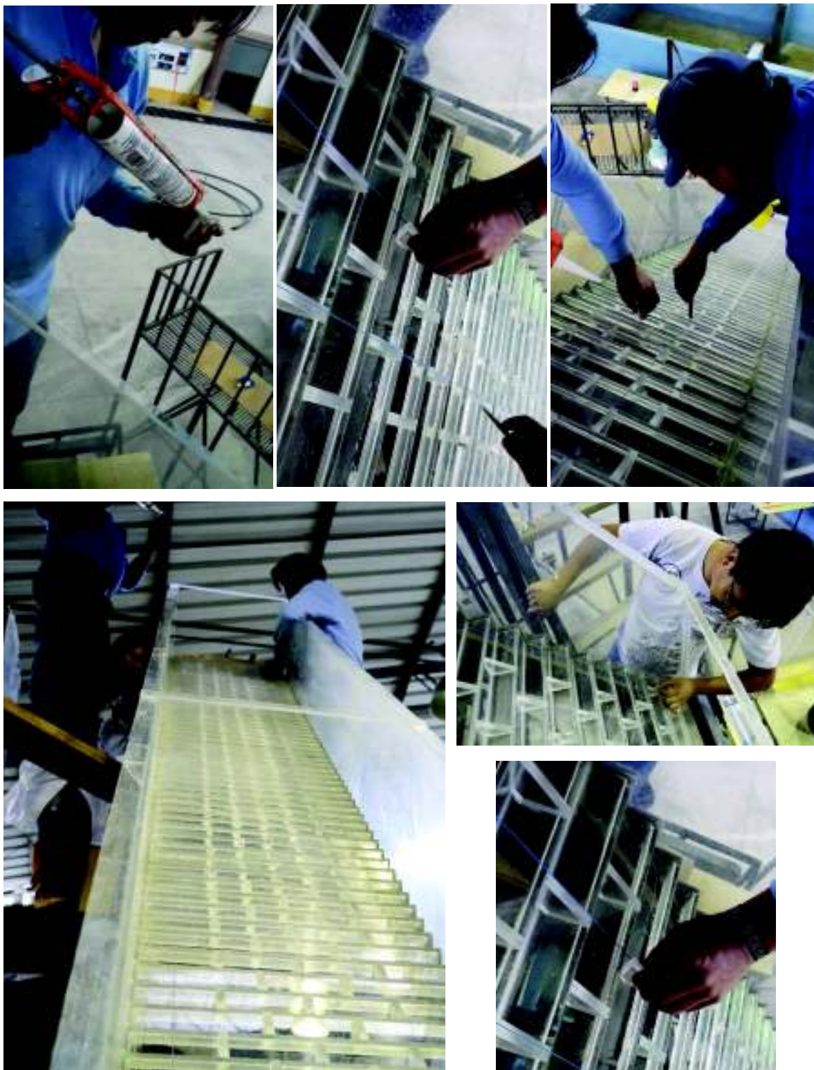
Fotografía No. 4: Colocación de tabiques triangulares
