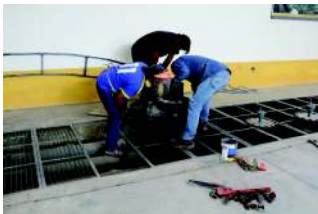
Fotografía No. 5: Colocación de la válvula de compuerta
