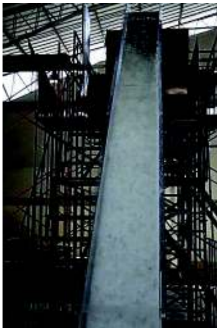
Fotografía No. 3.15: Rápida de fondo escalonado
