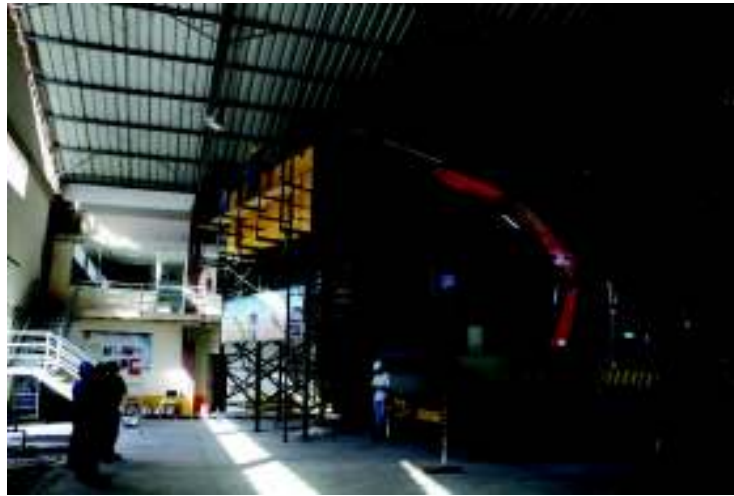
Fotografía No. 3: Camión grúa necesario para reubicar el tanque de abastecimiento
