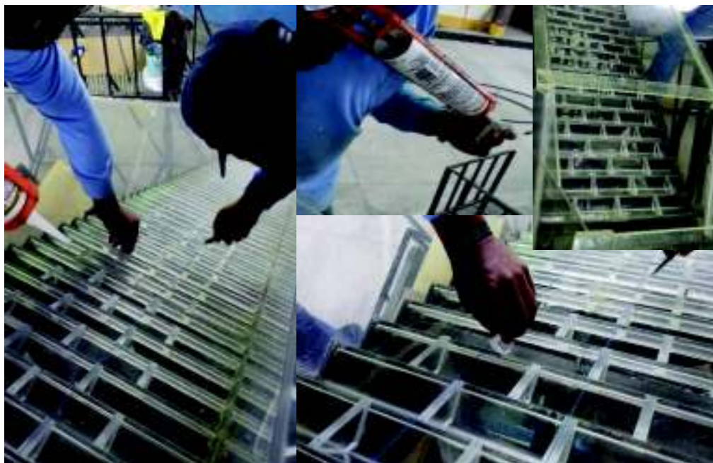
Fotografía No. 4.37: Colocación de tabiques triangulares a lo largo de toda la rápida escalonada
