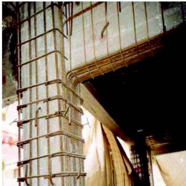
Figura 50 Encamisado de Viga - Columna
