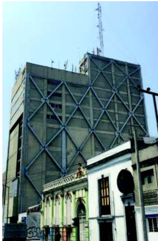
Fotografía 3 Reforzamiento mediante braces externos - México
