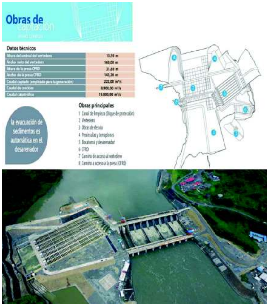
Figura 1.10. Obras de captación (CELEC EP, 2017)
