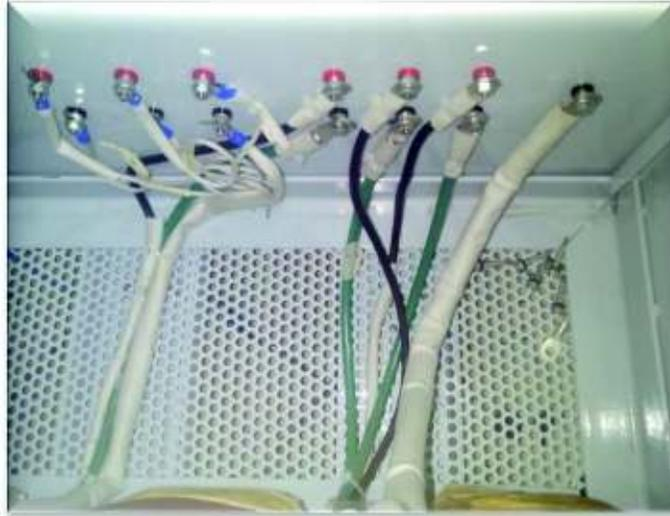
**Figura A4.12.** Conexión de terminales de los devanados del autotransformador
