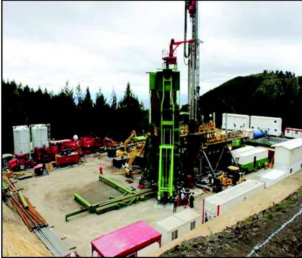
Figura 8: Taladro de Perforación Proyecto Chachimbiro – 1000 HP
