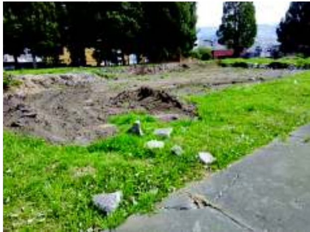
Figura II. Lugar en donde se encontraba la Planta de biogás. (FUEL & GUALOTUÑA, 2018).
