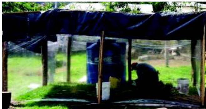
Figura 2.14. Cubierta de sistema de generación de energía eléctrica (Fuente: Elaborado por autor, 2018)
