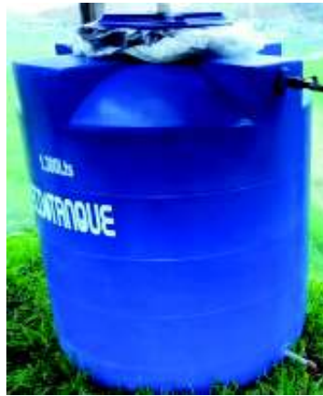
Figura 2.16. Tanque de polietileno instalado (Fuente: Elaborado por autor, 2018)
