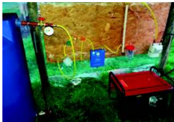
Figura 2.17. Ensamble de tubería, accesorios y equipos (Fuente: Elaborado por autor, 2018)
