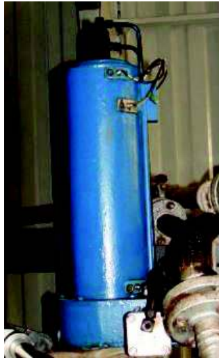
Figura 2.7. Torre del Rascador de la Centrifuga.
