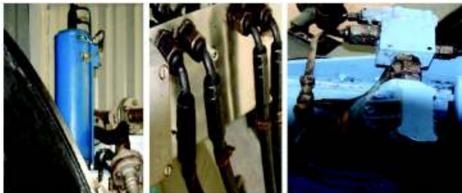
Figura 3.6. Conexiones de cañerías del circuito hidráulico y comprobación de fugas.
