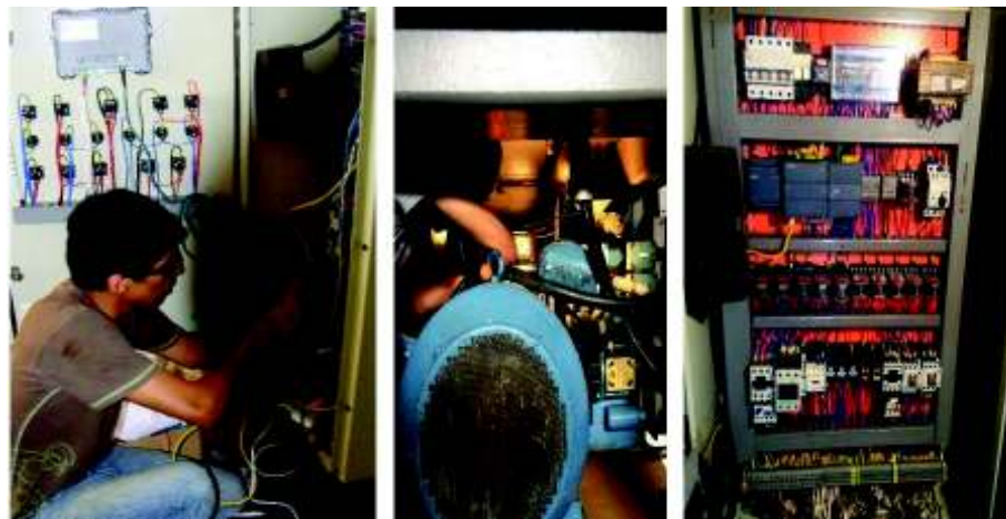
Figura 3.2. Realización de conexiones eléctricas.
