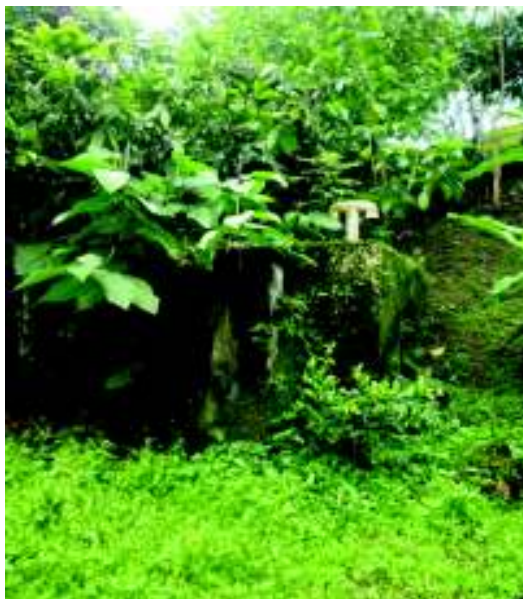
FIGURA 4.11 POZO SÉPTICO DE LA COOPERATIVA LOS ALMENDROS, MARZO 2018.
