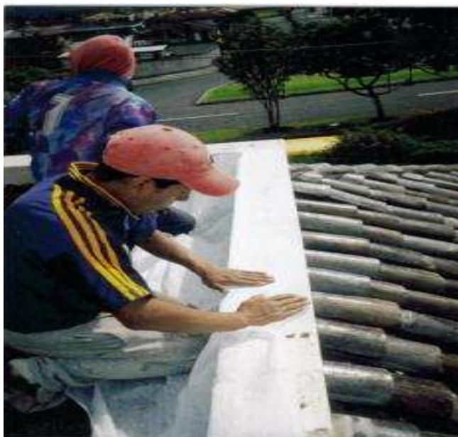
Foto N°29.- Colocación de malla súper refuerzo, en cubierta de residencia s/n en el sector de Cumbayá.
