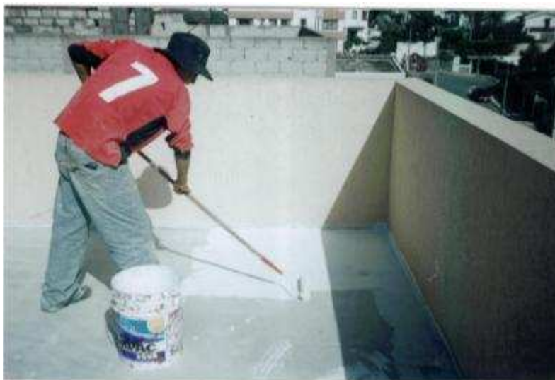
Foto N°30.- Aplicación capa final, en edificio Torr es del Pinar sector Quito Norte.
