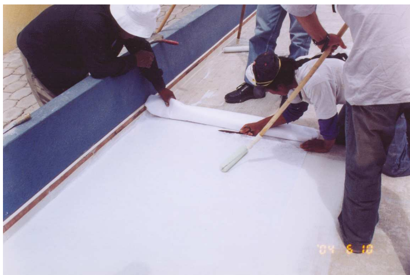
Foto N°23.- Forma de colocación de la membrana IMP AC, en cubierta de residencia s/n.
