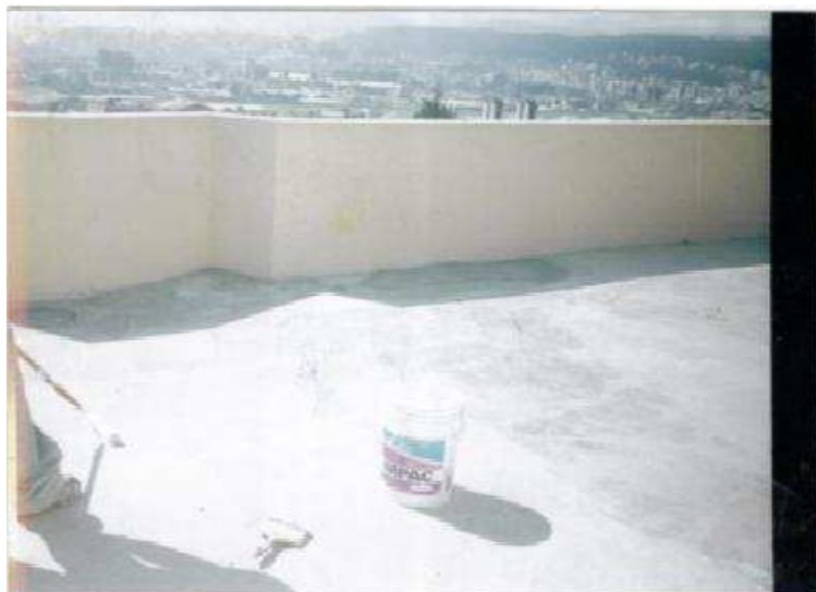
Foto N°28.- Aplicación IMPAC SELLO, en edificio Torres del Pinar.
