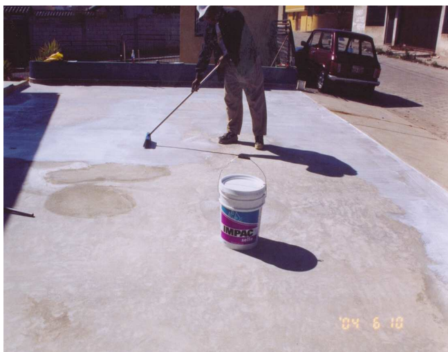
Foto N°21.- Aplicación de IMPAC SELLO en patio de residencia s/n.
