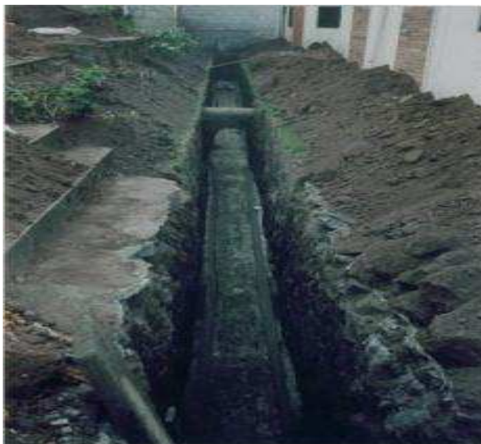
Foto N° 25.- Limpieza de una superficie enterrada, para impermeabilizar en residencia s/n, Cumbayá.
