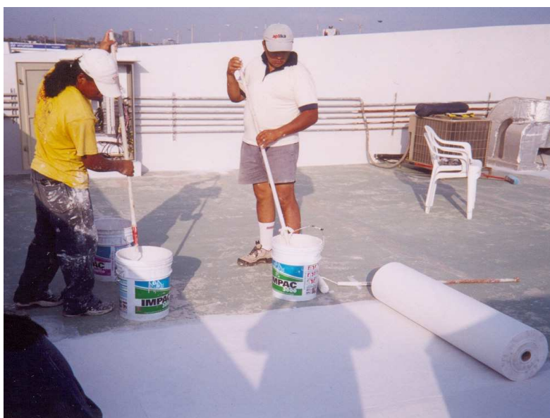
Foto N° 17.- Forma de aplicación del IMPAC SELLO y del IMPAC 3000, en Edificio Torres del Pinar.
