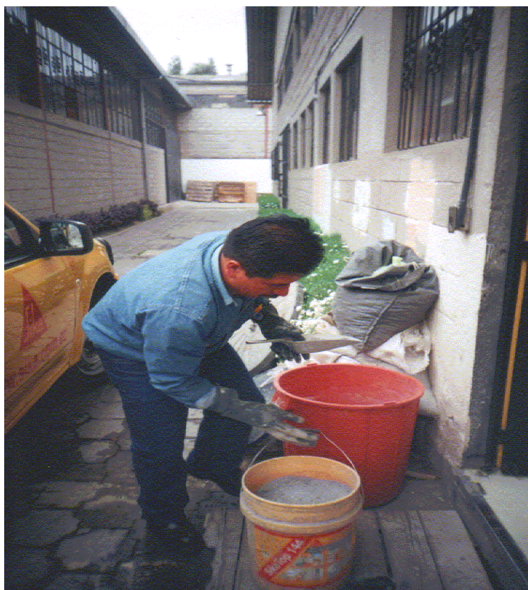
Foto N°4.- Toma de materiales en sus porcentajes e especificados en laboratorio Sika, para construcción s/n.
