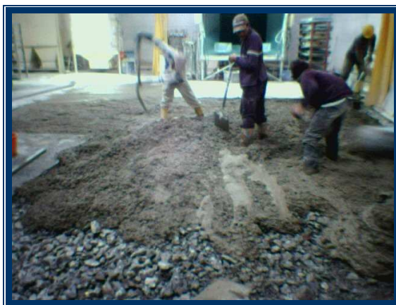
Foto N°2.- Fundición de una capa de hormigón
