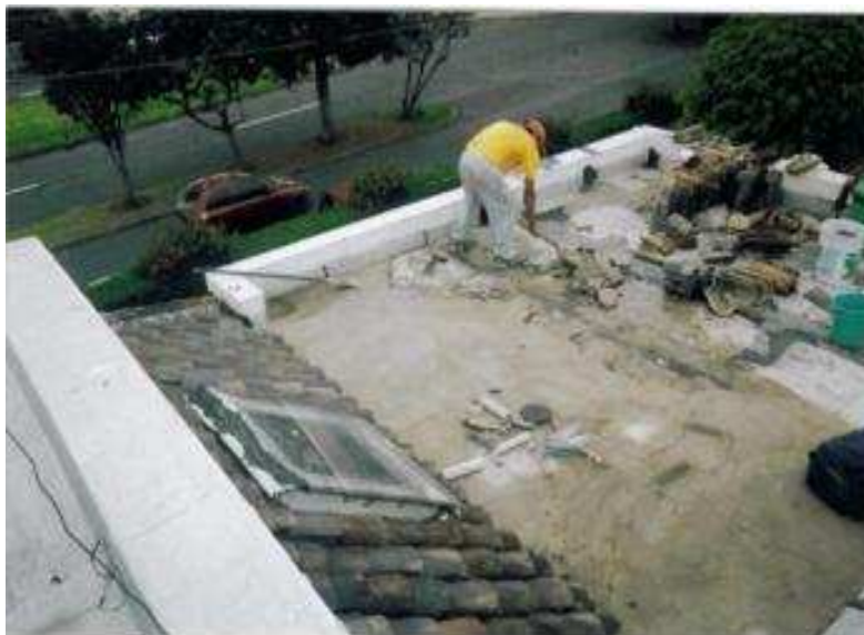
Foto N°27.- Limpieza integral de cubierta para impermeabilizar en residencia s/n, sector Cumbayá.
