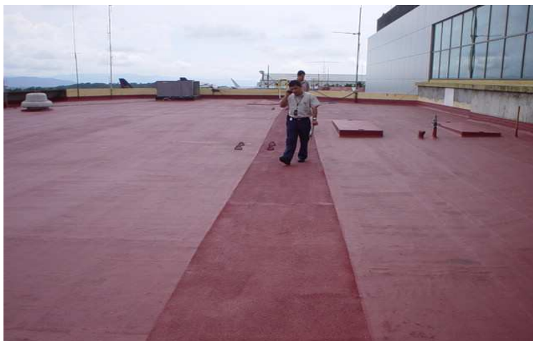
Foto N° 20.- Acabado final con IMPAC PREMIUM, losa transitable, aeropuerto de Puerto Rico.
