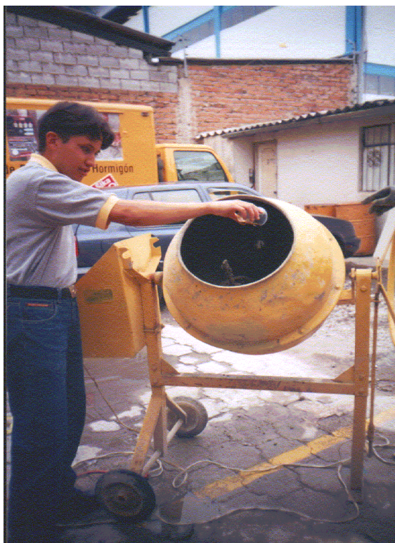
Foto N°8.- Colocado de aditivo en su porcentaje especificado, en la mezcla.
