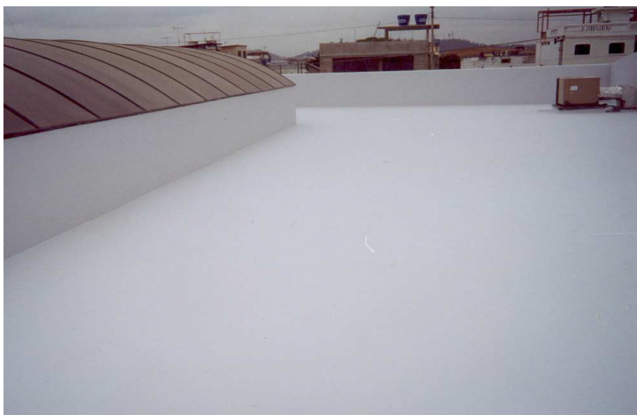
Foto N°19.- Acabado final con IMPAC 7000, color blanco, en cubierta de fábrica s/n.
