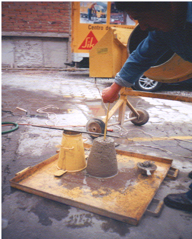
Foto N°9.- Colocado de aditivo en su porcentaje es pecificado, en la mezcla.
