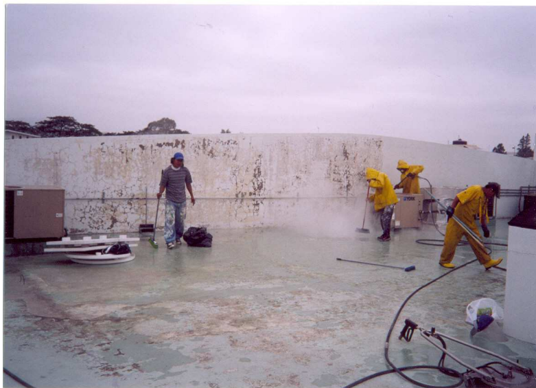
Foto N° 26.- Hidrolavado en cubierta para impermeabilizar en residencia s/n.
