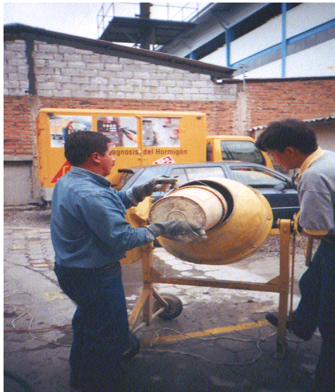
Foto N°6.- Colocado de materiales en sus porcentajes especificados en concretera.
