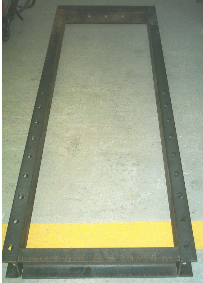
Fig. 3.12 Estructura principal previo a la soldadura
