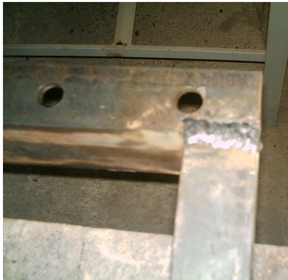
Fig. 3.13 Soldadura de refuerzo con electrodo E 7018
