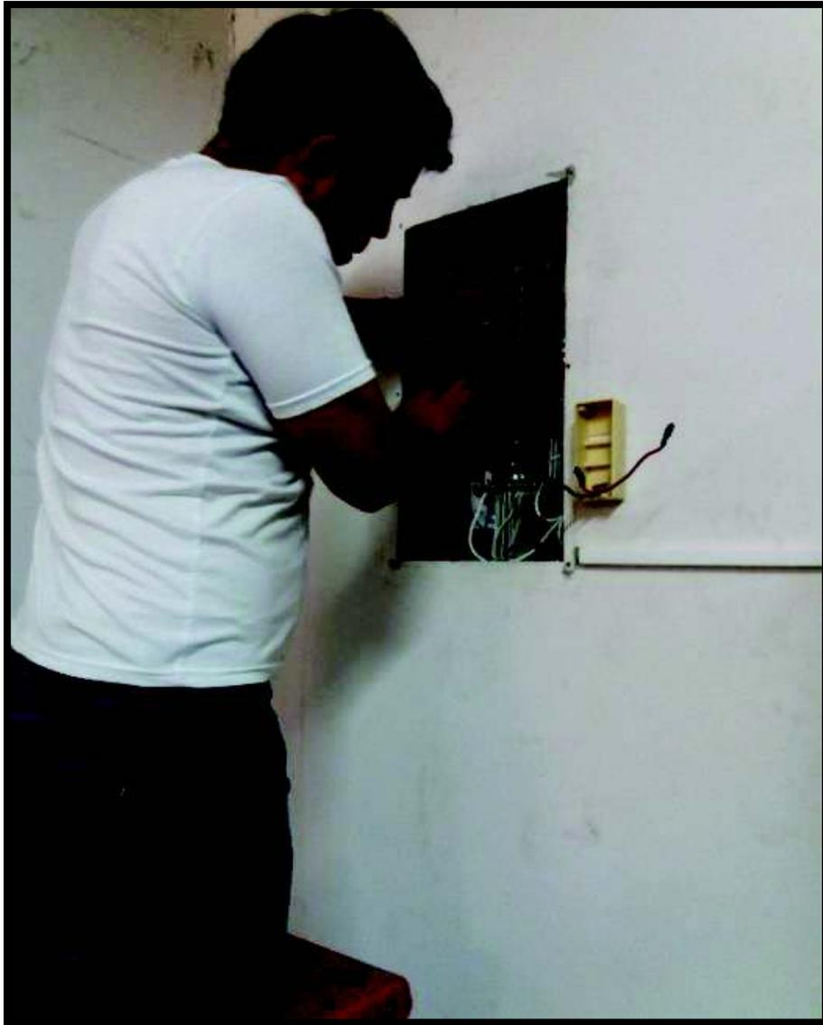
Figura 38: Conexión del disyuntor al panel eléctrico
