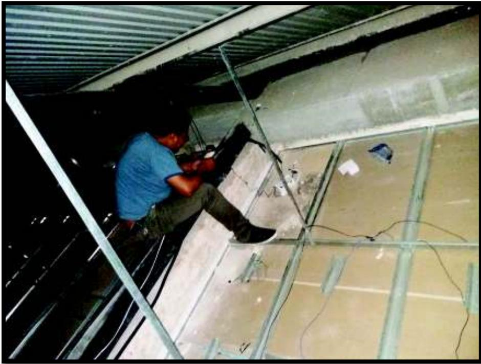
Figura 40: Conexión de cámaras.
