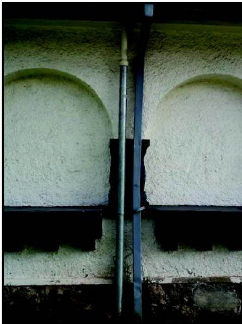
Figura 30: Tubería metálica 3"
