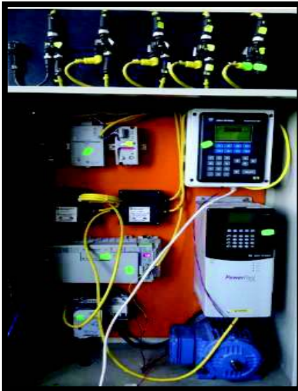
Figura 2.26 Módulo de Red DeviceNet
