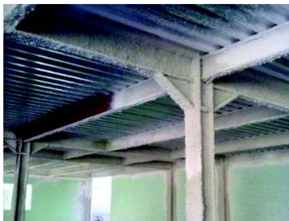
FIGURA 5.40 Mortero ignífugo en estructuras de acero
