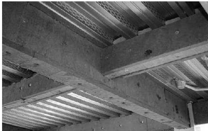
FIGURA 5.43 Vigas protegidas por placas de lana mineral
