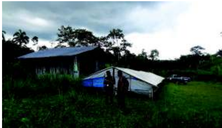
Figura 78 - Terreno para la construcción de planta
