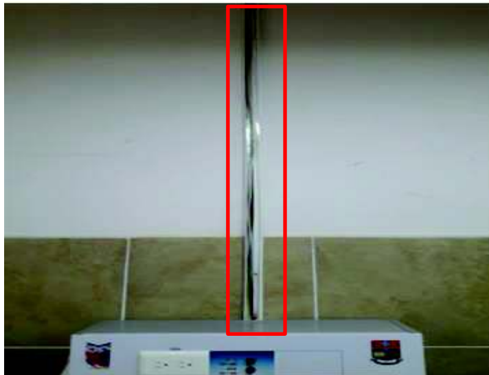
Figura 31. Instalación de bajantes (Fuente Propia)
