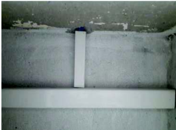
Figura 32. Instalación de canaletas para las mesas de trabajo (Fuente Propia)
