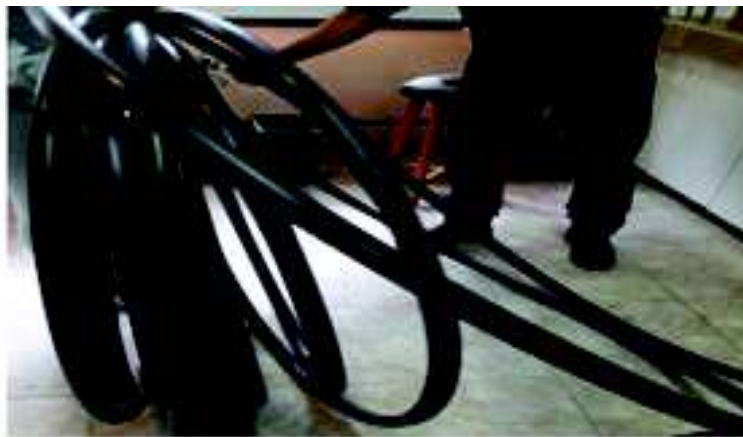
Figura 27. Instalación de la ductería (Fuente Propia)
