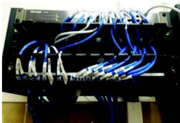
Figura 22. Instalación del equipo de telecomunicaciones (Fuente Propia)
