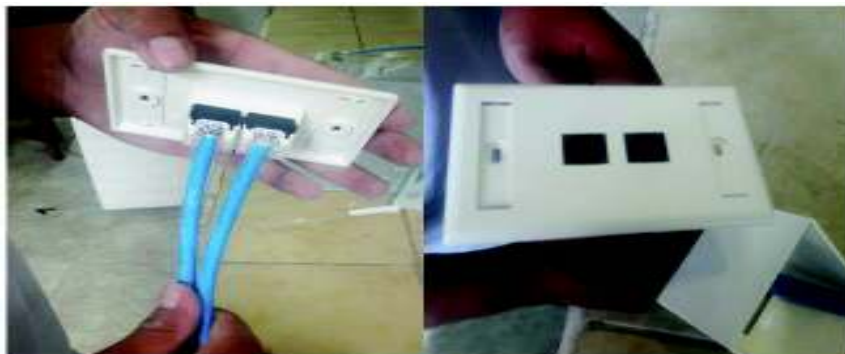
Figura 20. Instalación de los puntos de red (Fuente Propia)
