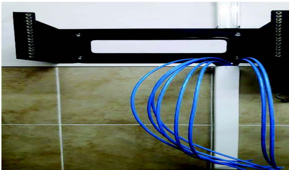
Figura 28. Instalación de la canalización (Fuente Propia)
