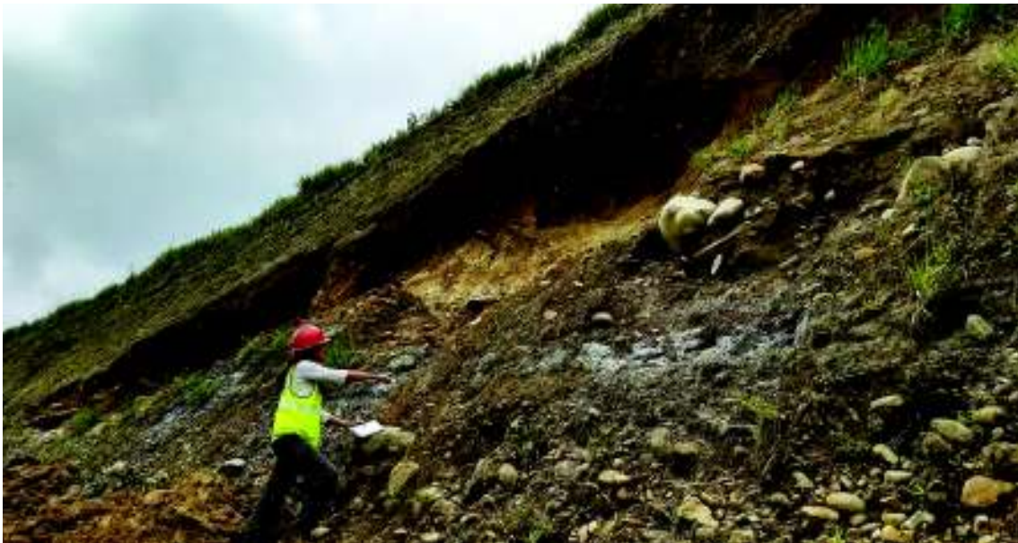
Fotografía 4.14 Deslizamiento D-015. (UTM, WGS 84: 757224E; 18627N).
