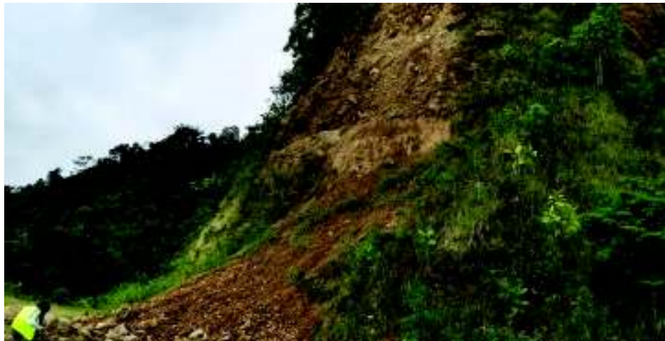
Fotografía 4.1 Materiales de naturaleza sensible y colapsable que causan pérdida de resistencia al corte del suelo. (UTM, WGS 84: 757041E; 21081N).
