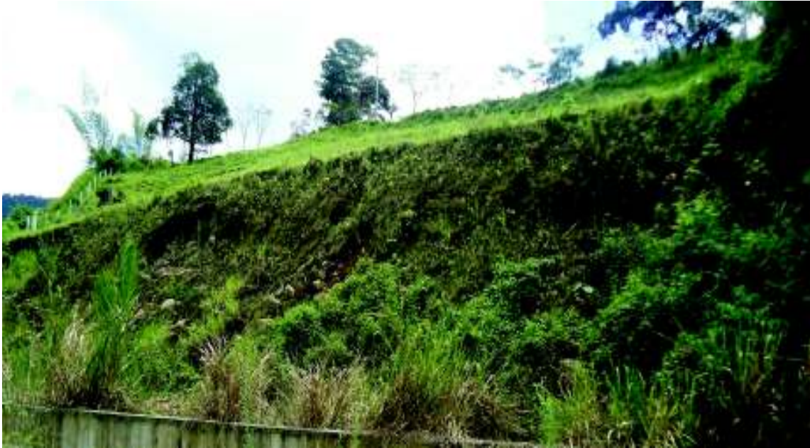
Fotografía 4.3 Deslizamiento D-016. (UTM, WGS 84: 757594E; 17436N).
