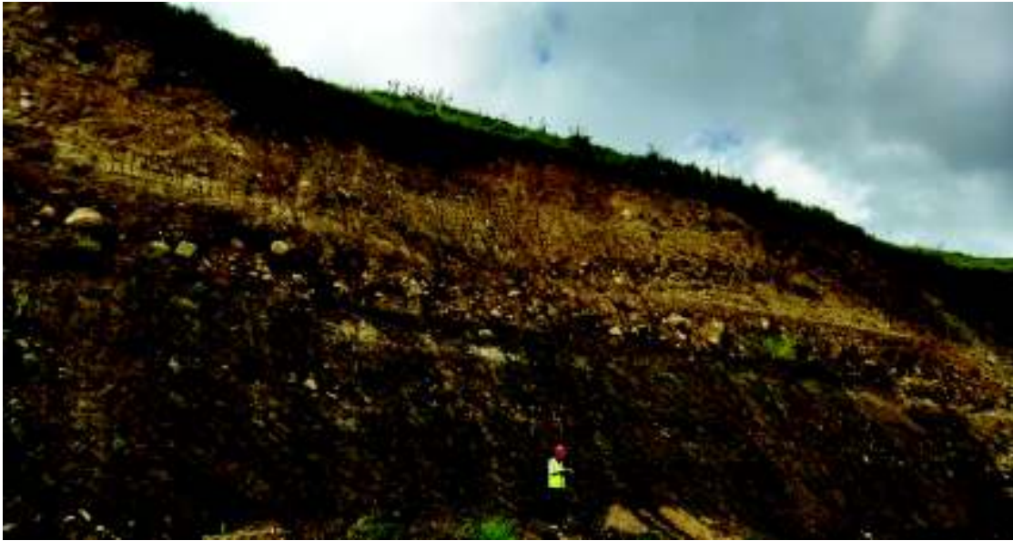
Fotografía 4.11 Deslizamiento D-005. (UTM, WGS 84: 757079E; 18441N).
