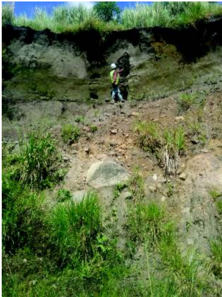
Fotografía 4.21 Deslizamiento D-010. (UTM, WGS 84: 756742E; 20178N).
