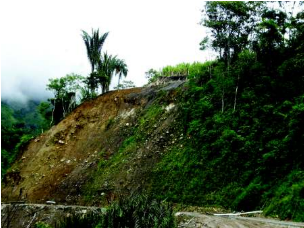
Fotografía 4.5 Deslizamiento DD-004. (UTM, WGS 84: 757332E; 17636N).
