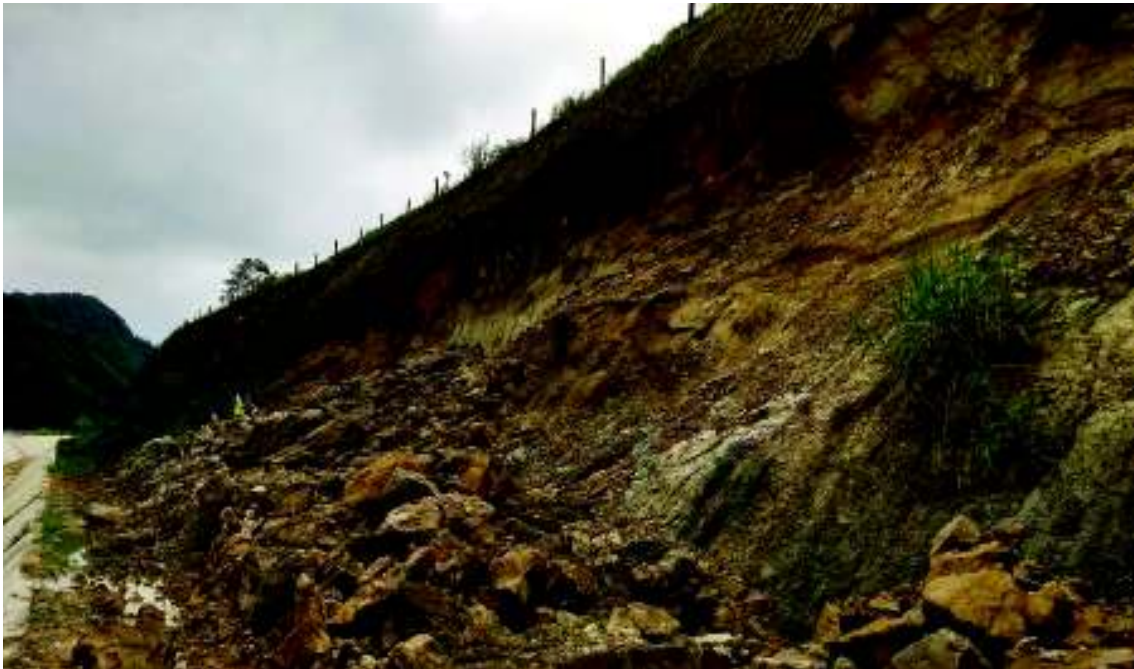
Fotografía 4.16 Deslizamiento D-013. (UTM, WGS 84: 757178E; 18793N).
