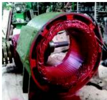
Figura 2.33 Terminado del bobinado y barnizado
