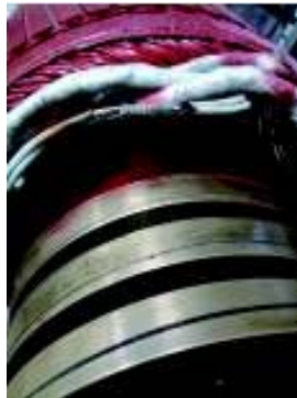
Figura 2.18 Terminado de conductores soldados
