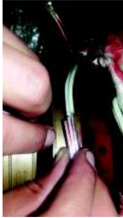
Figura 2.16 Unión de conductores con hilo de aluminio
