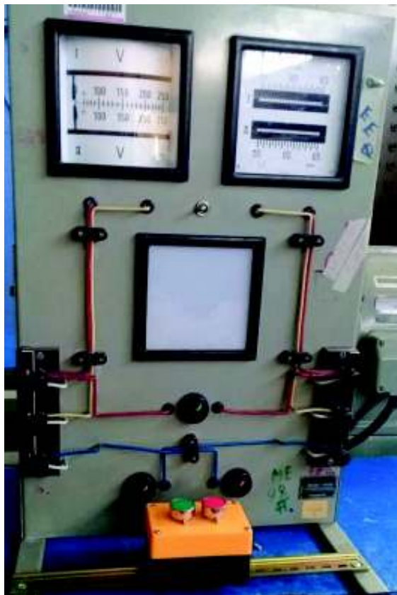
Figura A7.2 Reparación del tablero de sincronismo
