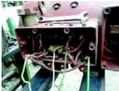
Figura 3.12 Conexión experimental de armadura y campo con fuentes independientes
