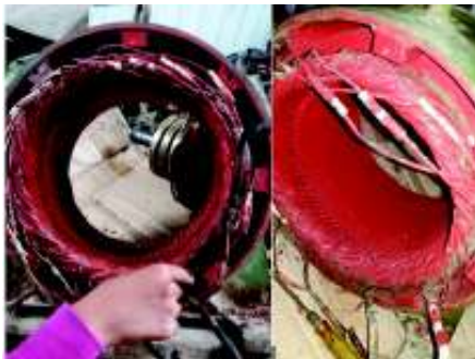
Figura 2.24 Extracción de puntos de solda del interior de la carcasa del estator y retiro del aislamiento de los bobinados
