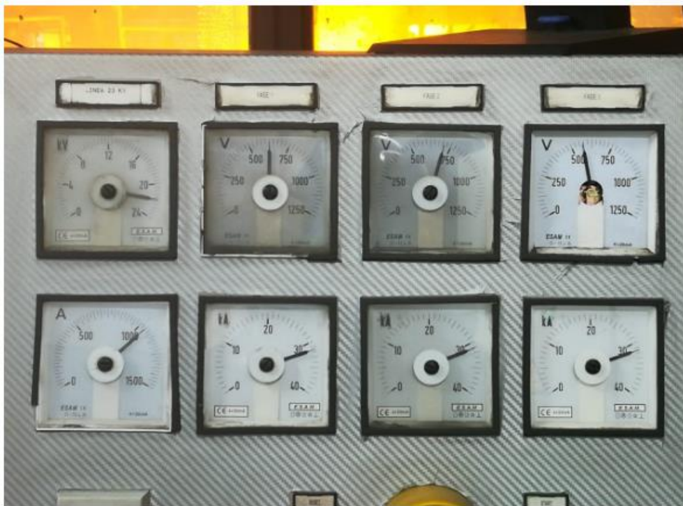
Figura 3.23. Arco inestable en equipos de medida. (Fuente: Registro Analizador de Energía, Planta Adelca)
