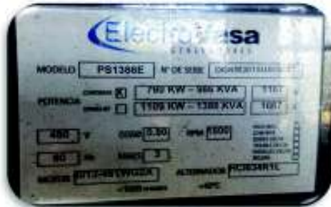
Placa de la unidad de generación térmica a utilizarse como compensador sincrónico
