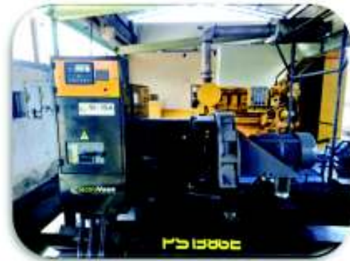
Compensador sincrónico (Vista lateral)
