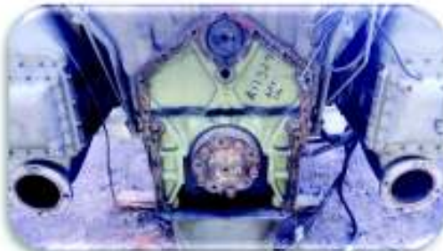
Motor de combustión interna siniestrado, eje de acople al generador sincrónico
