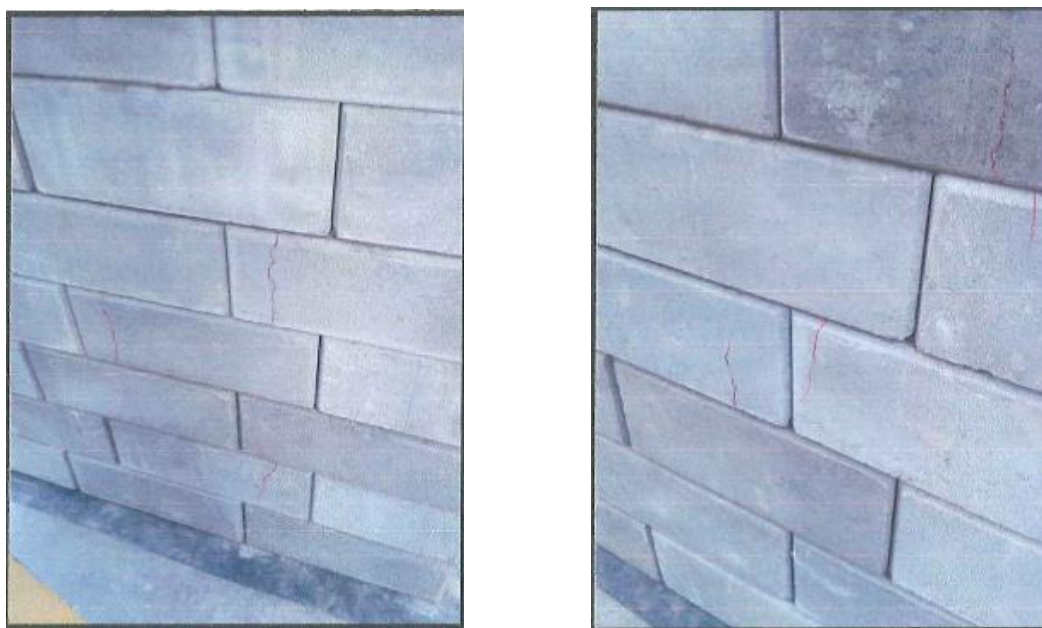
Fotografía 3.1: Fallas en murete A, ensayo de compresión axial
