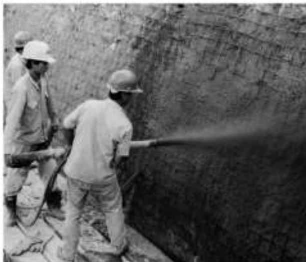
Figura 2. 10 Colocación del concreto lanzado. Tomado de (Suarez, 2009)
