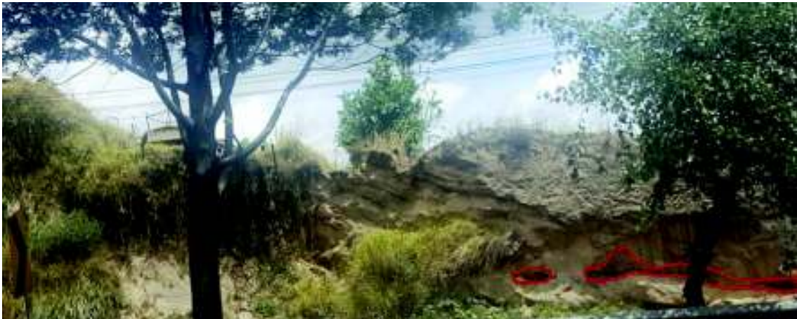
Figura 5. 3 Pérdida de soporte en las capas de cangahua por socavación de las capas de caída.
