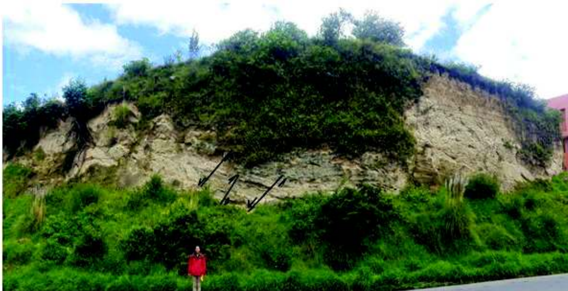
Fotografía A. 3 Presencia de fallas locales, columna C3.
