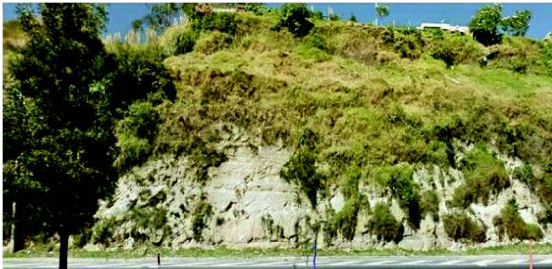
Fotografía A. 13 Capas afectadas por erosión superficial por lluvia y viento.
