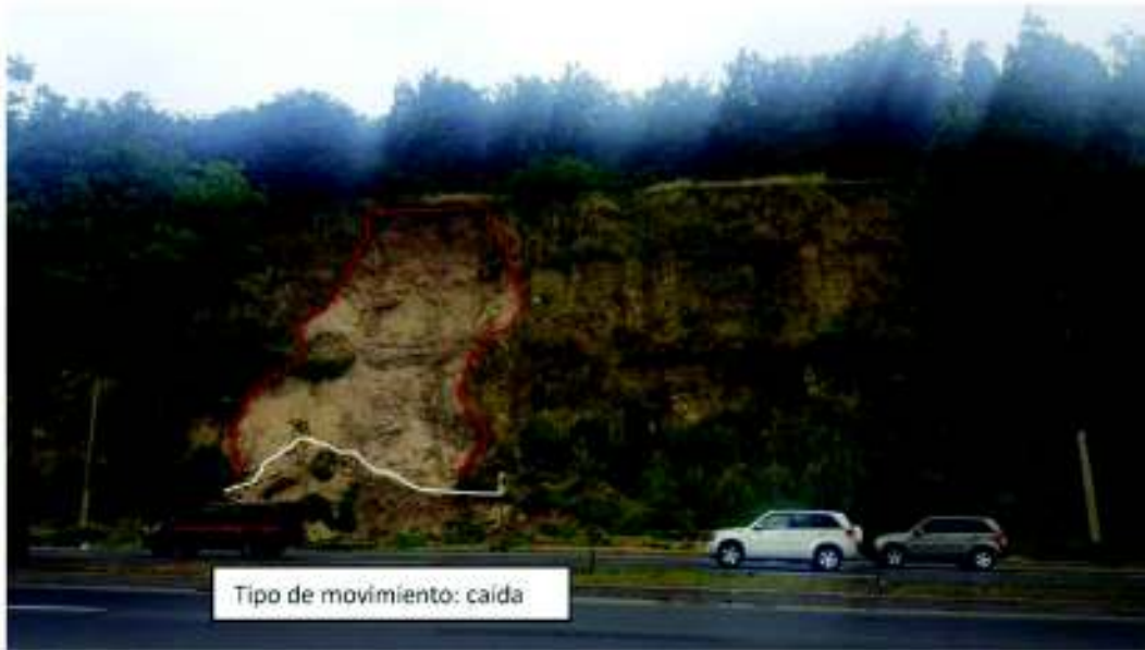
Fotografía B. 1 Movimiento en masa de tipo caída: UTM: X: 777410.8; Y: 9970353, sector La Forestal
