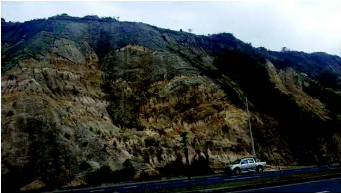
Fotografía A. 9 Capas afectadas por erosión superficial por lluvia y viento, columna C9.
