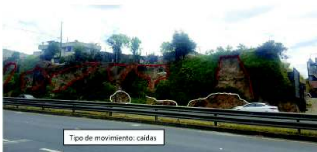
Fotografía B. 4 Movimiento en masa de tipo caída: UTM: X: 778439.7; Y: 9973191.7, sector Loma de Puengasí.
