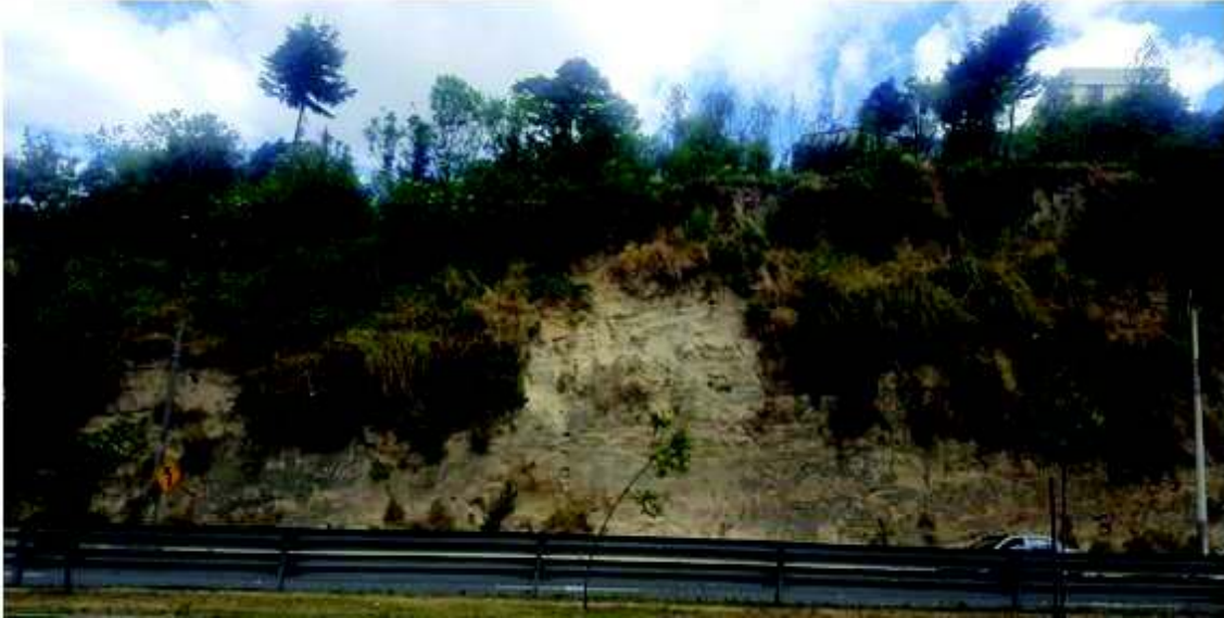
Fotografía A. 11 Talud sin vegetación con el cual se pudo levantar la columna C11.
