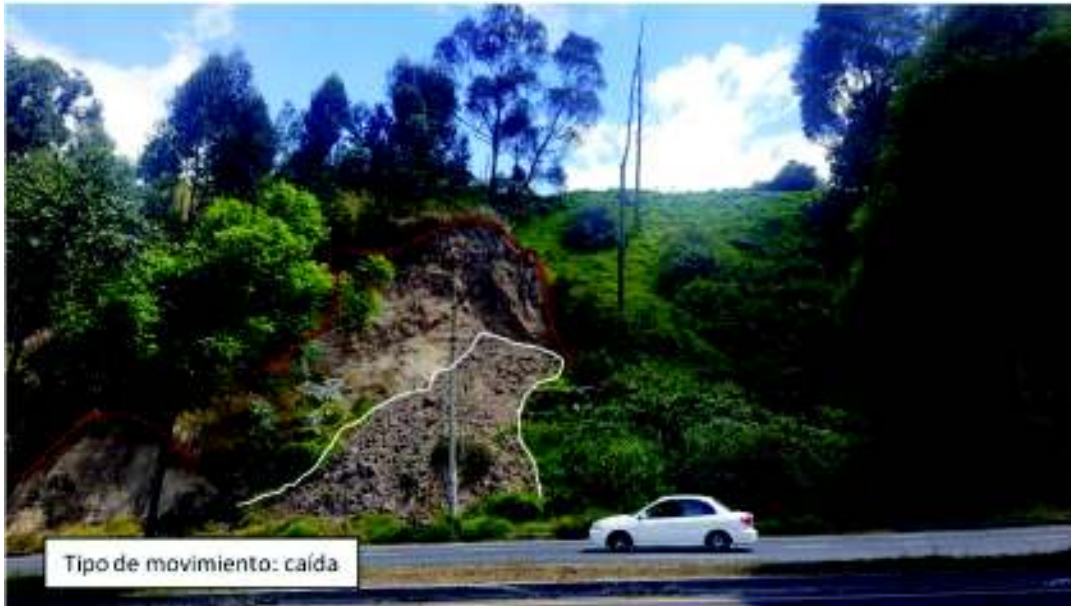
Fotografía B. 5 Movimiento en masa de tipo caída: UTM: X: 779548.1; Y: 9974078.1, sector San Pedro de Monjas.
