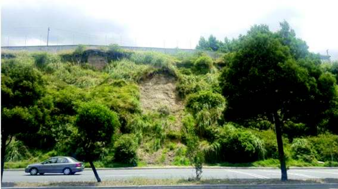
Fotografía A. 12 Capas afectadas por erosión superficial por lluvia y viento, columna C12.
