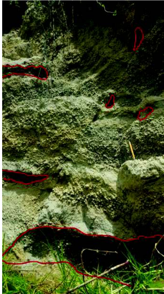
Figura 5. 2 Evidencia de socavación en las capas de caída
