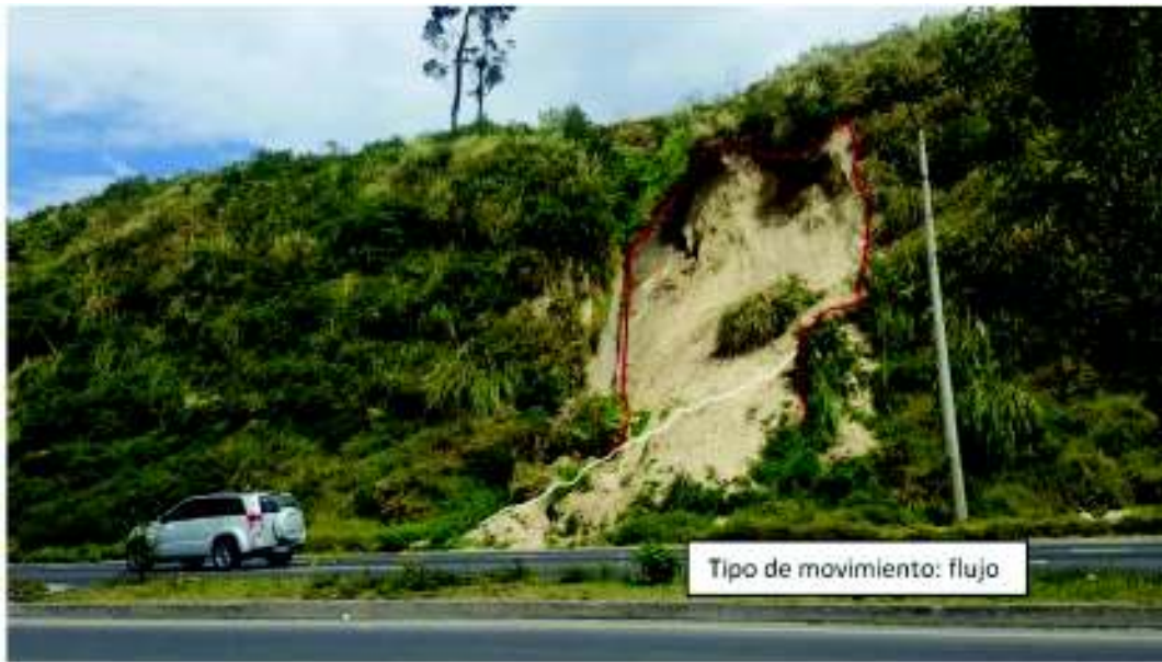
Fotografía B. 3 Movimiento en masa de tipo flujo asociado a una caída inicial: UTM: X: 777720.5; Y: 9971015.7, sector La Forestal.
