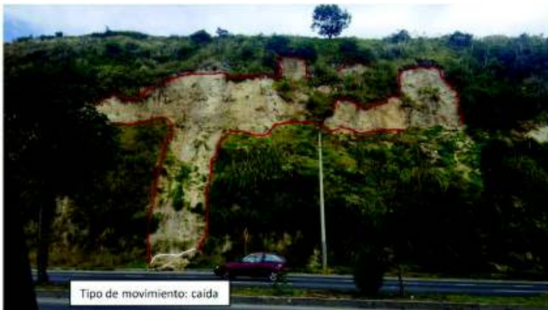
Fotografía B. 2 Movimiento en masa de tipo caída: UTM: X: 777102.1; Y: 9969629.9, sector La Argelia.
