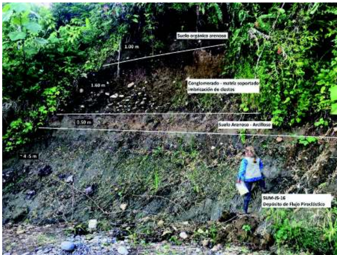
Figura 3.36 Afloramiento en la comunidad de Boca del Suno, localizado en el margen izquierdo del río Suno. A la base, se observa el posible depósito de flujo piroclástico de composición traquibasáltica, perteneciente al volcán Sumaco. La muestra coleccionada es SUM–JS-16. (246150/9924246, 363 msnm / UTM WGS84-18S).
