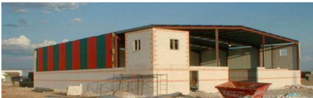
**Fig 2.12** Estructura metálica con paredes divisorias
