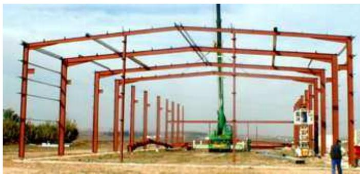
Fig 2.9 Estructura sin pilares intermedios
