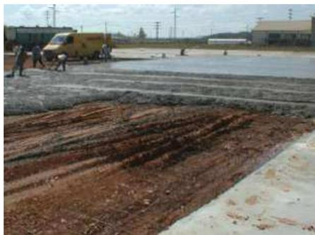
**Fig 2.8** Ejecución de una solera
