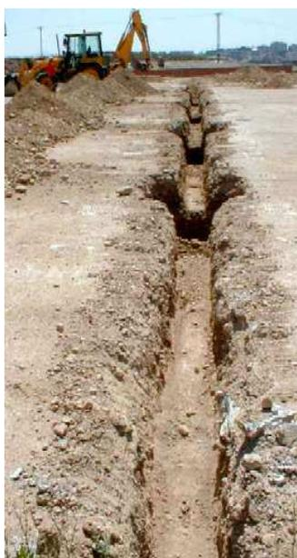
**Fig 2.6** Excavación de una cimentación
