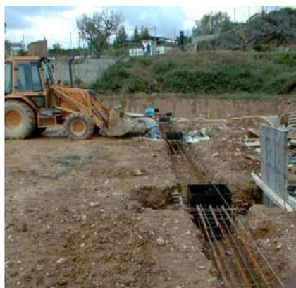
**Fig. 2.7** Armado de la cimentación
