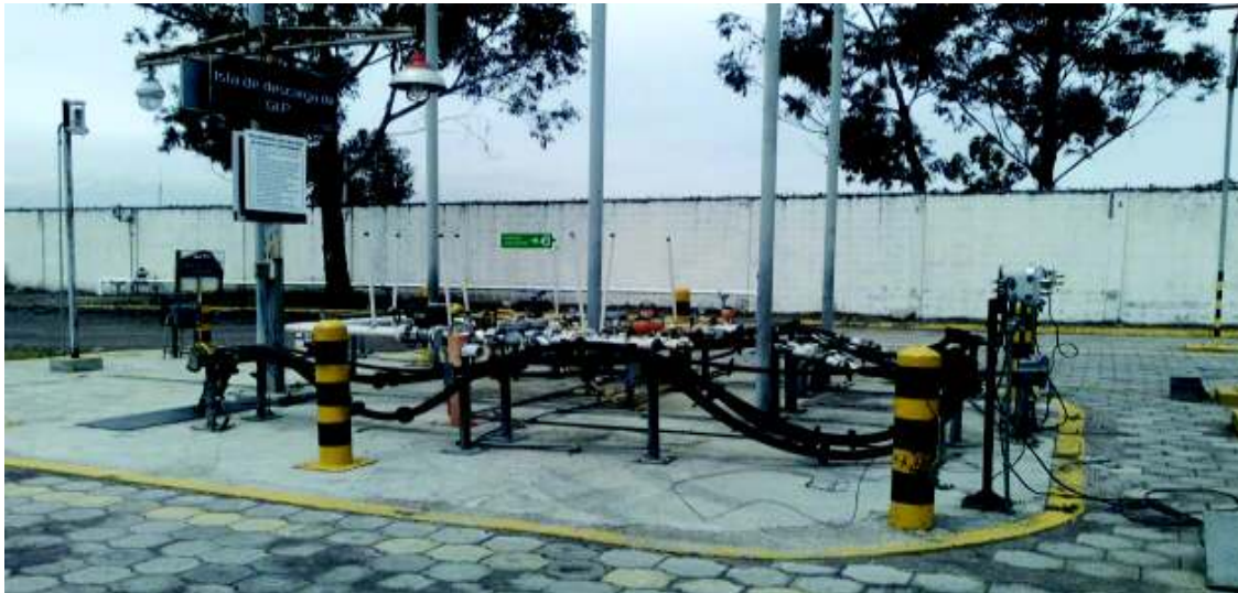
Figura 1.4. ISLA DE CARGA Y DESCARGA EN UNA PLANTA DE ALMACENAMIENTO Y ENVASADO DE GLP
